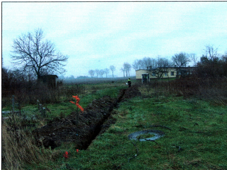
Fot. 4) Siemidrożyce gm. Kostomłoty dz. nr 80/1 przyłącze kablowe. Północny kraniec wykopu. Widok z północnego-zachodu
