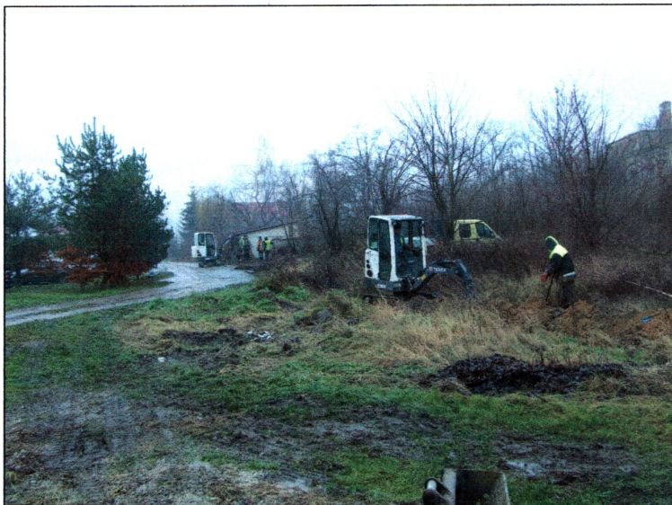
Fot. 2) Siemidrożyce gm. Kostomłoty dz. nr 80/1 przyłącze kablowe. Środkowa część wykopu. Widok z północy
