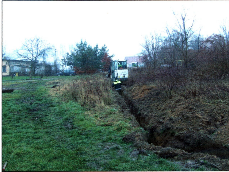
Fot. 3) Siemidrożyce gm. Kostomłoty dz. nr 80/1 przyłącze kablowe. Środkowa część wykopu. Widok z północnego-zachodu
