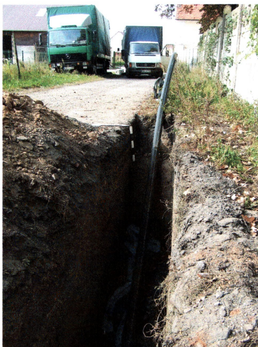
fol. 1 Fragment wykopu inwestycyjnego na odcinku A-B
