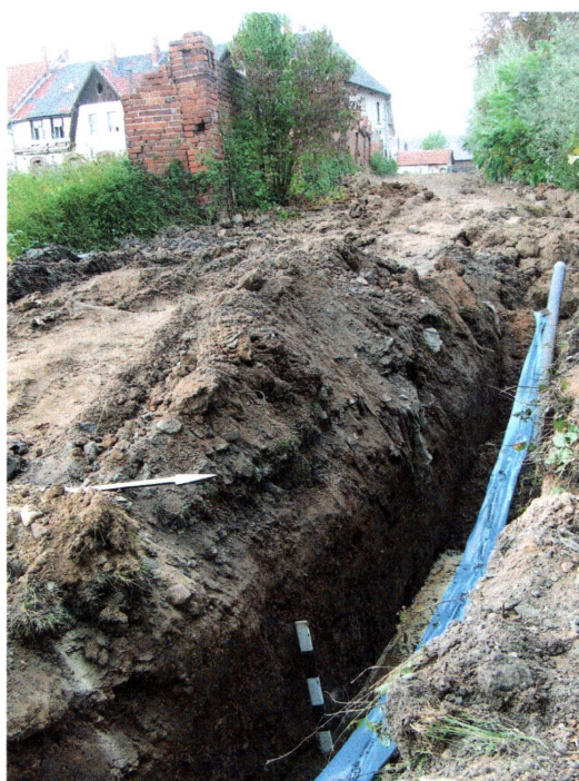
fot. 3 Fragment wykopu inwestycyjnego na odcinku B-C
