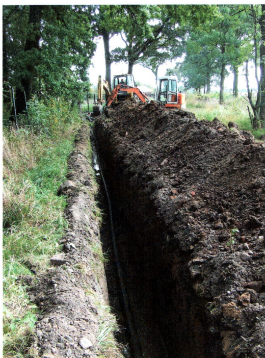
fol. 5 Fragment wykopu inwestycyjnego na odcinku C-D
