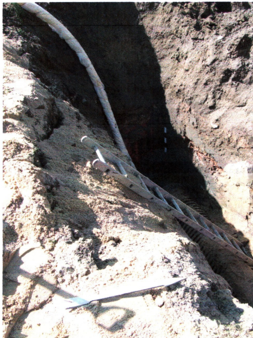
fot. 3 Wykop pod przyłącze kanalizacji sanitarnej. Ujęcie od wschodu
