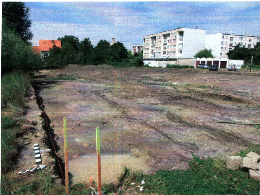
fol. 2 Widok na obszar przeznaczony pod główne boisko po zdjęciu wierzchniej warstwy nakładu ziemi do gł. 0,2-0,3 m. Ujęcie od południowego wschodu
