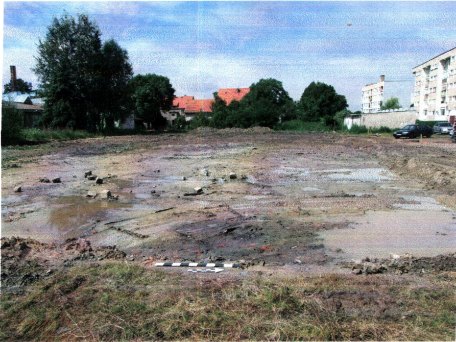
fol. 1 Widok na obszar przeznaczony pod główne boisko po zdjęciu wierzchniej warstwy nakładu ziemi do gł. 0,2-0,3 m. Ujęcie od wschodu
