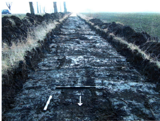
Fot. 8. Widok na wykop na N od zakrętu głównej drogi
