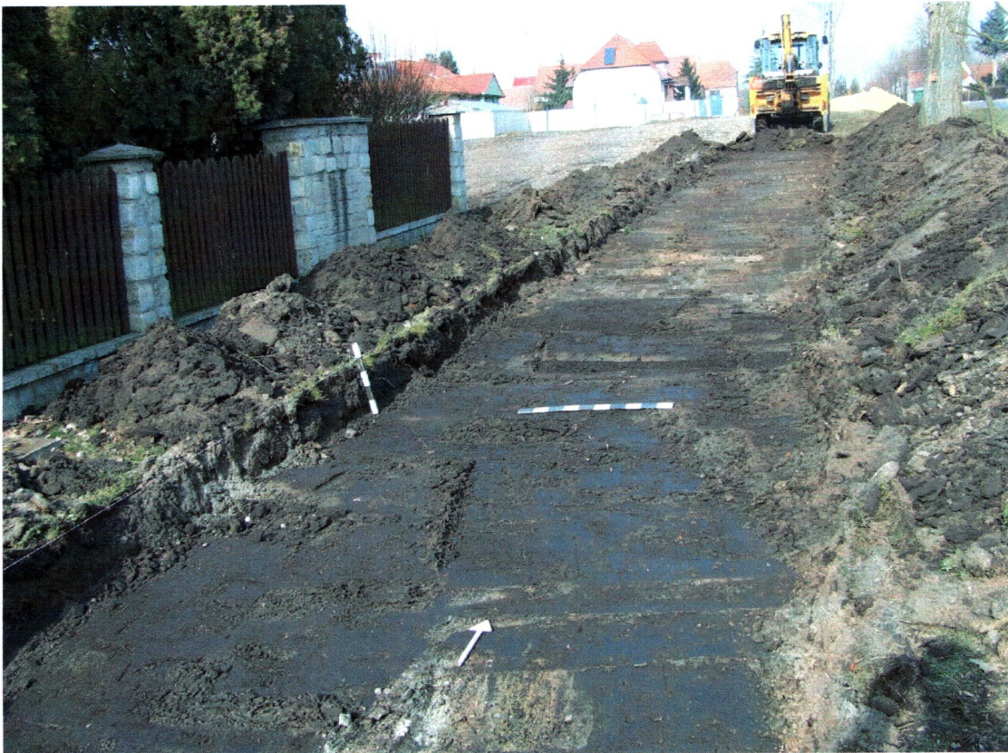
Fot. 12. Widok na wykop w pobliżu posesji nr 1g
