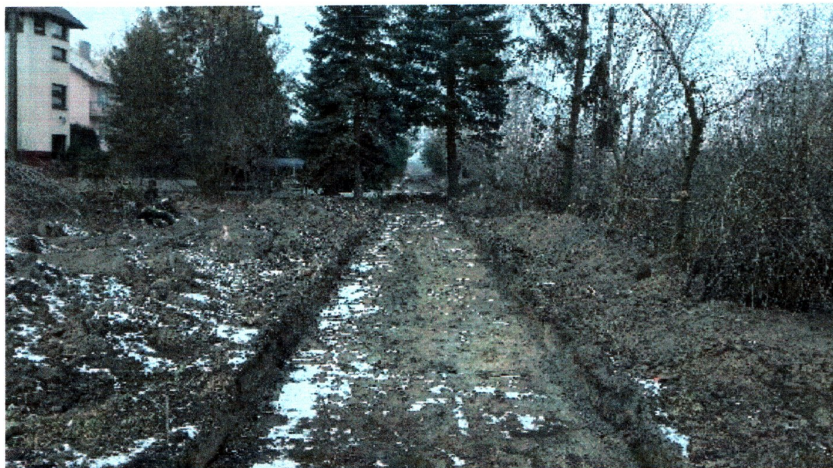
Fot. 1. Widok od SE na wykop w okolicy posesji nr 14 i 15 w Kostomłotach
