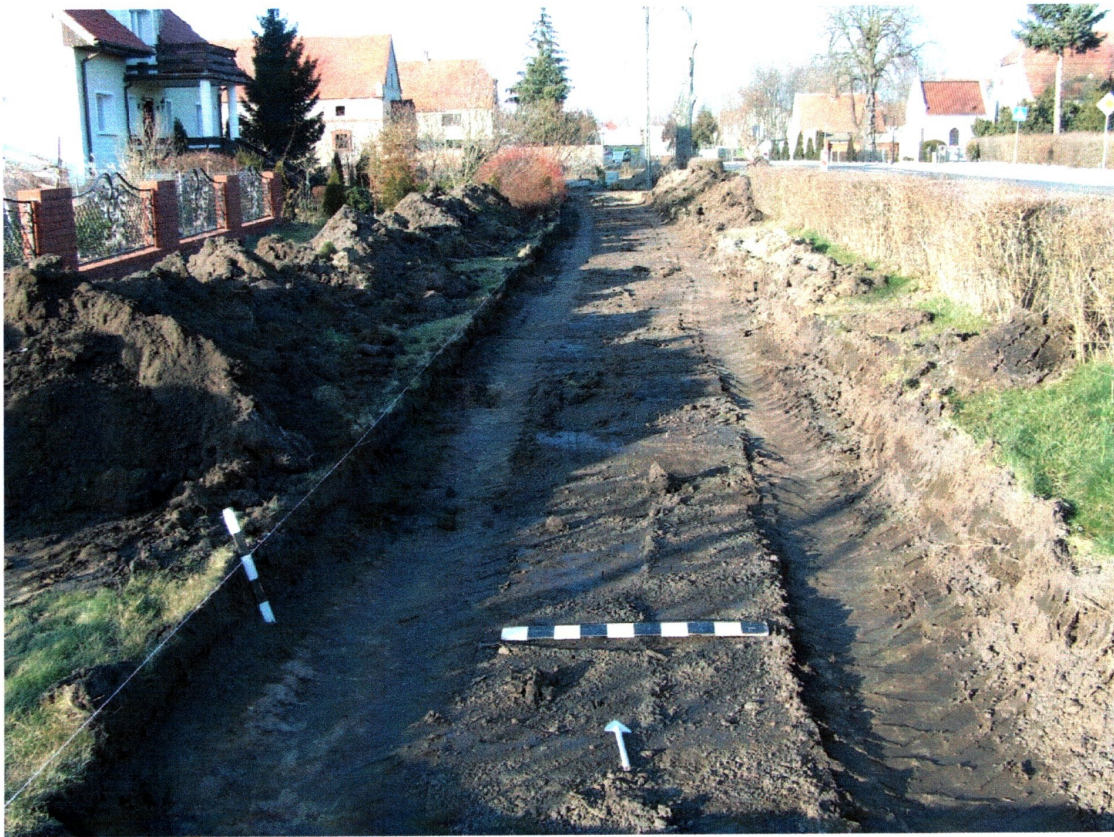
Fot. 13. Widok na wykop w okolicy posesji nr 1e
