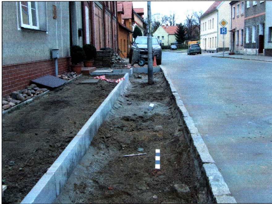
Fot. 3) Środa Śląska ul. Daszyńskiego dz. nr 76. Widok spągu wykopu wraz z widokiem profilu południowego. Widok z zachodu
