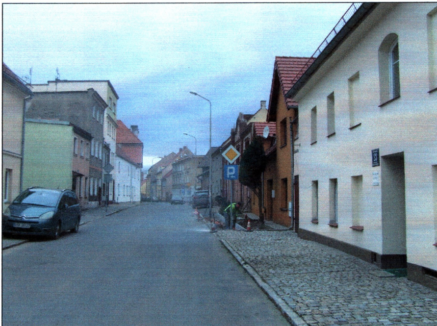
Fot. 2) Środa Śląska ul. Daszyńskiego dz. nr 76. Widok wschodniej części wykopów. Widok z południowego-wschodu
