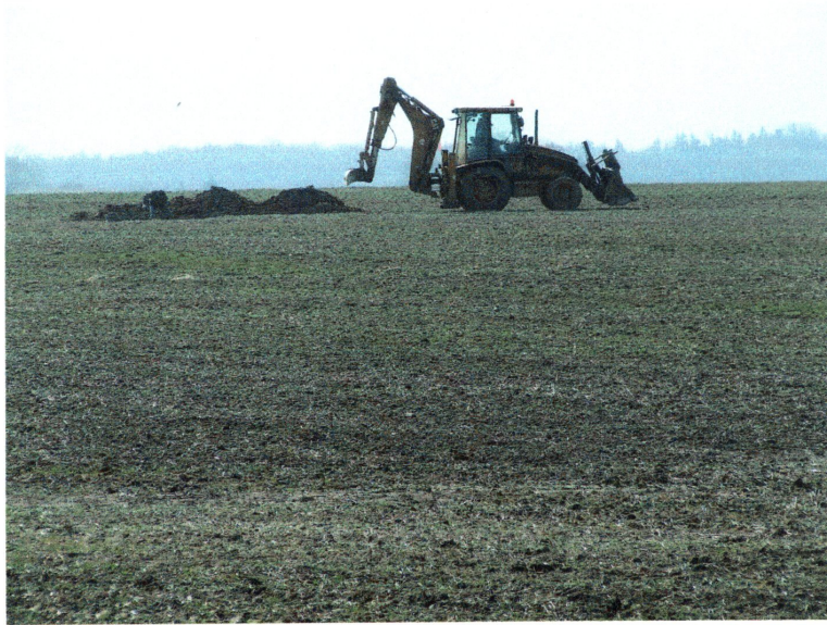
fol. 1 Rozpoczęcie prac badawczych – szurf I, odcinek IA. Widok od strony północnej
