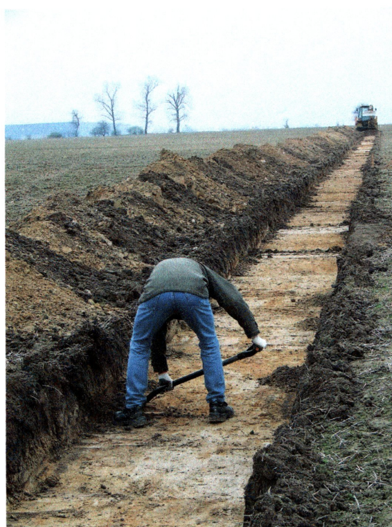
fot. 34 Prace przy doczyszczaniu powierzchni odcinka IVA
