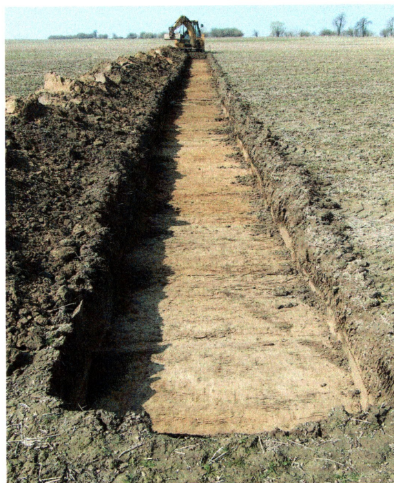
fol. 2 Prace na odcinku IA. Widok od strony wschodniej
