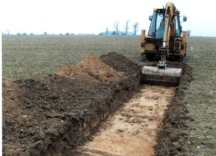
fot. 33 Początek prac w obrębie szurfu IV
