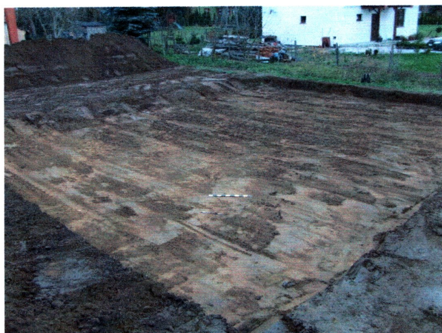
Fot. 2. Widok od E na odhumusowany teren pod budynek
