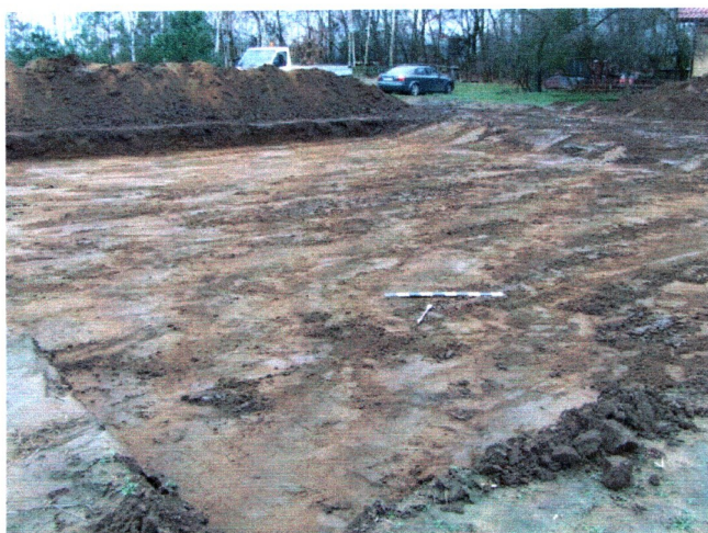
Fot. 1. Widok od N na odhumusowany teren pod budynek
