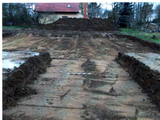
Fot. 3. Widok na odhumusowany teren pod drogę dojazdową i budynek
