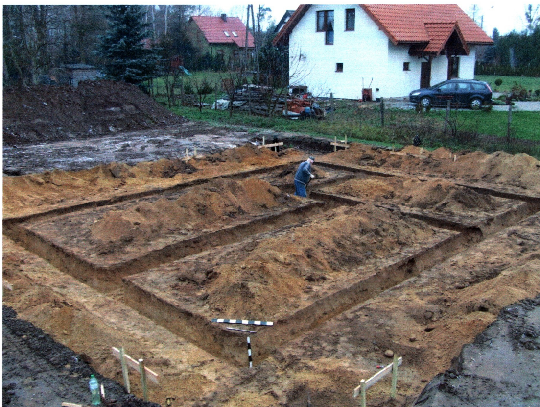
Fot. 7. Widok od E na gotowe wykopy pod łąwy fundamentowe
