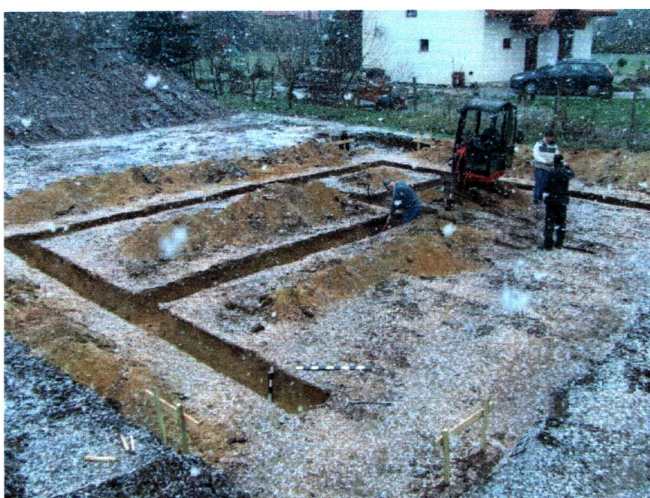
Fot. 6. Widok na rowy fundamentowe w trakcie kopania
