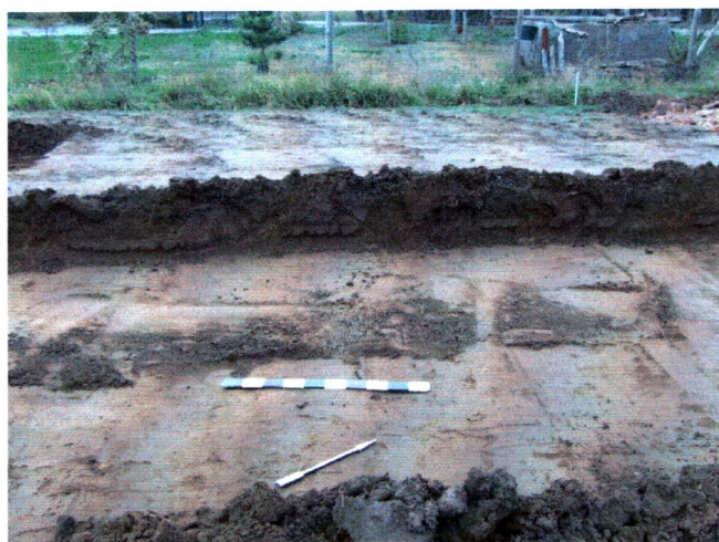
Fot. 4. Widok na odhumusowany teren pod drogę dojazdową
