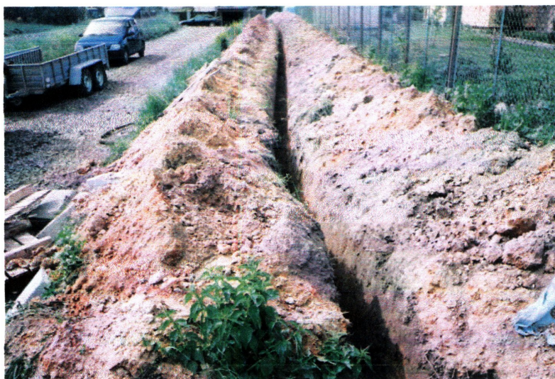
Fot. 1 Widok ogólny na główną nitkę wykopu pod wodociąg
