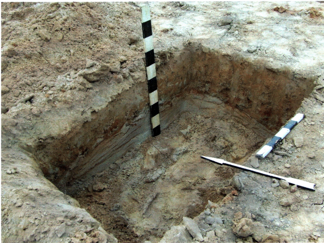
Fot. 12. Widok na wykop pod stopę fundamentową
