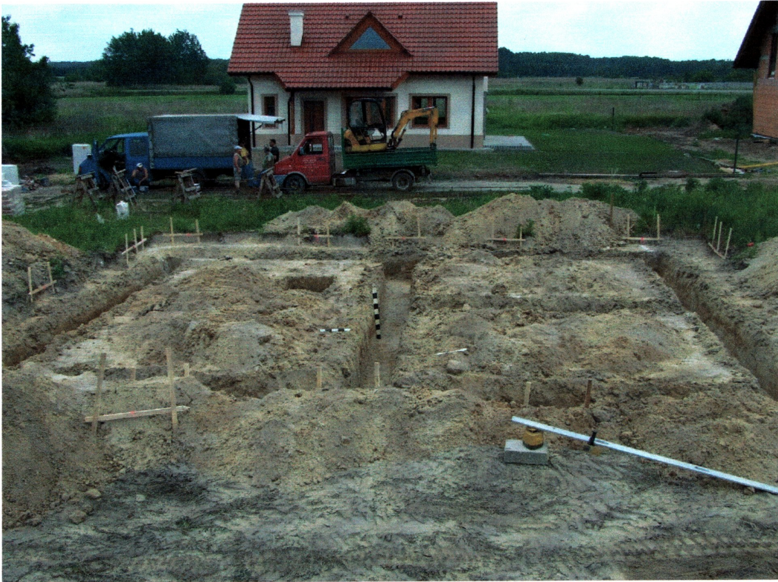
Fot. 4. Widok od W na wykopy fundamentowe
