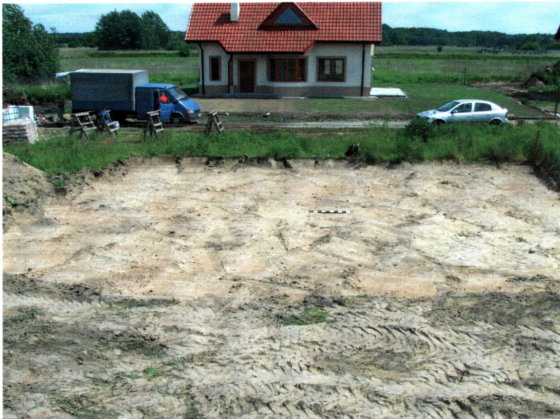
Fot. 1. Widok od W na odhumusowany wykop pod budynek
