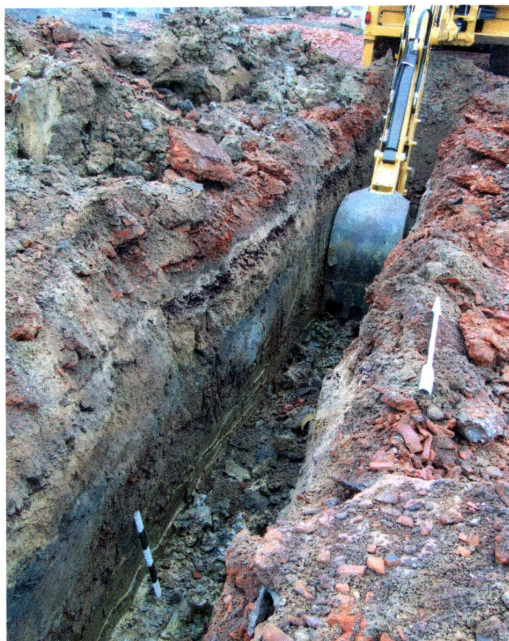
fot. 1 Realizacja wykopów w środkowej części inwestycji
