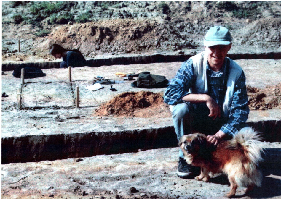
fot. 2 Widok na fragment wykopów pod ławy fundamentowe budynku mieszkalnego
