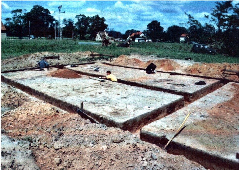
fot. 1 Widok ogólny na wykopy pod ławy fundamentowe budynku mieszkalnego
