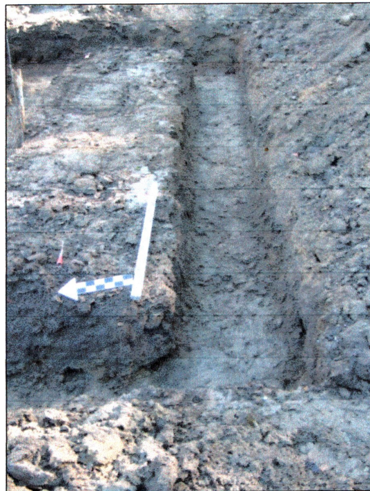
fot. 4 Wykop pod południową łąwę fundamentową
