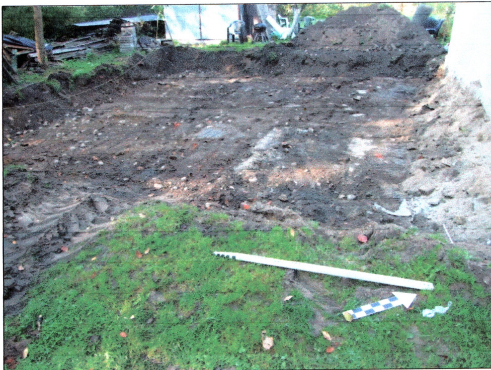
fot. 2 Obszar prac badawczych po zdjęciu mechanicznej warstwy mięszności około 0,5 m
