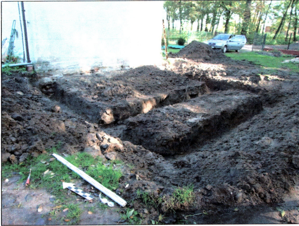
fot. 3 Widok ogólny wykopów pod łąwy fundamentowe
