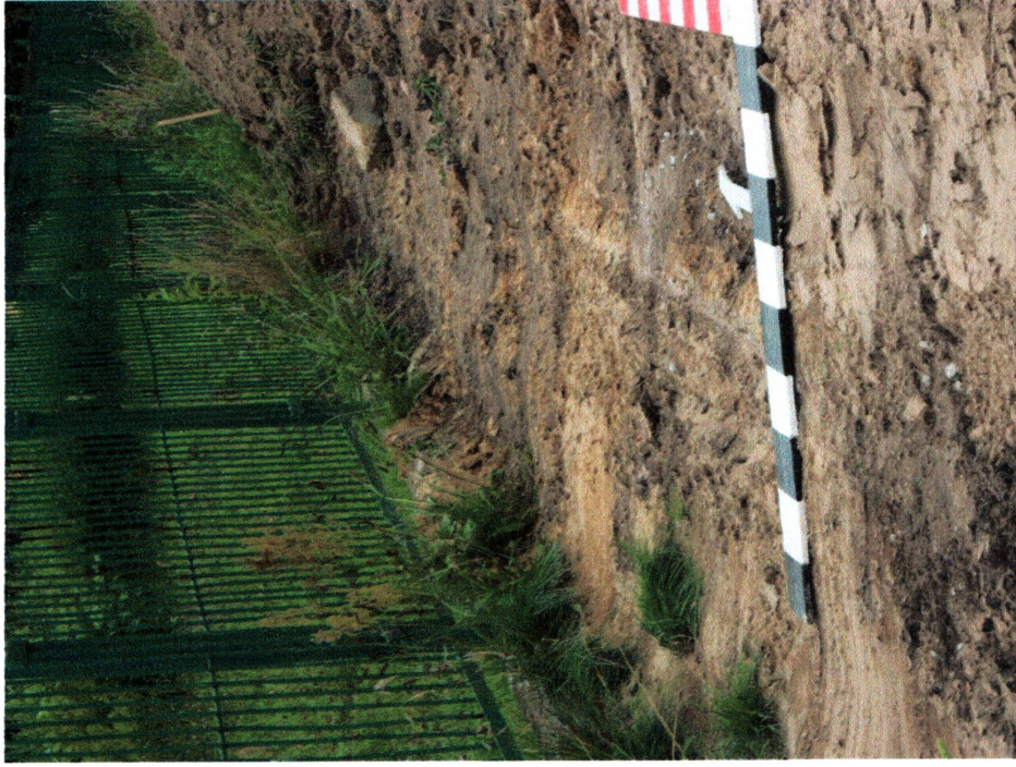
Ryc. 5. Miękinia, ul. Szkolna, Sportowa i Osiedłowa - modernizacja dróg gminnych: a -skorytowana nawierzchnia drogi pod ciąg pieszy na ul. Osiedłowej; b -skorytowana nawierzchnia drogi pod ciąg pieszy na ul. Szkolnej.
