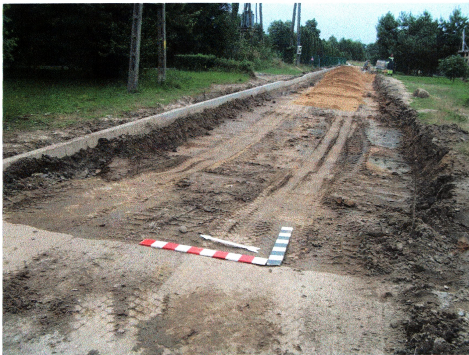
Ryc. 3. Miękinia, ul. Szkolna, Sportowa i Osiedlowa - modernizacja dróg gminnych: a - korytowanie z rozbiórką nawierzchni na ul. Szkolnej; b - skorytowana nawierzchnia drogi na ul. Osiedlowej.
