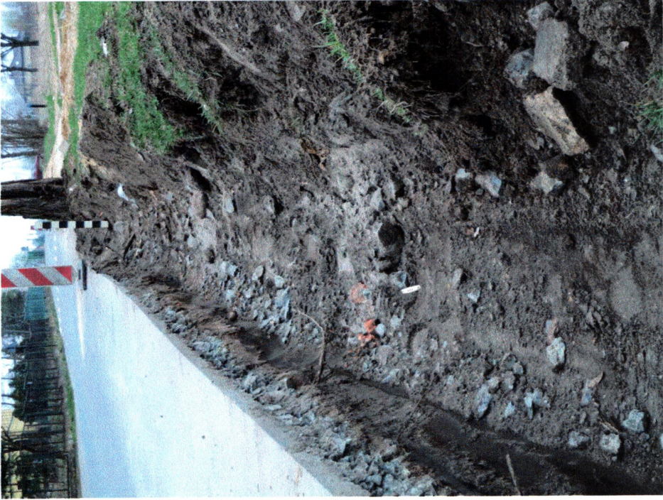
Ryc. 4. Miękinia, ul. Szkolna, Sportowa i Osiedlowa - modernizacja dróg gminnych: a -skorytowana nawierzchnia drogi na ul. Sportowej; b -skorytowana nawierzchnia drogi pod ciąg pieszy na ul. Osiedlowej.
