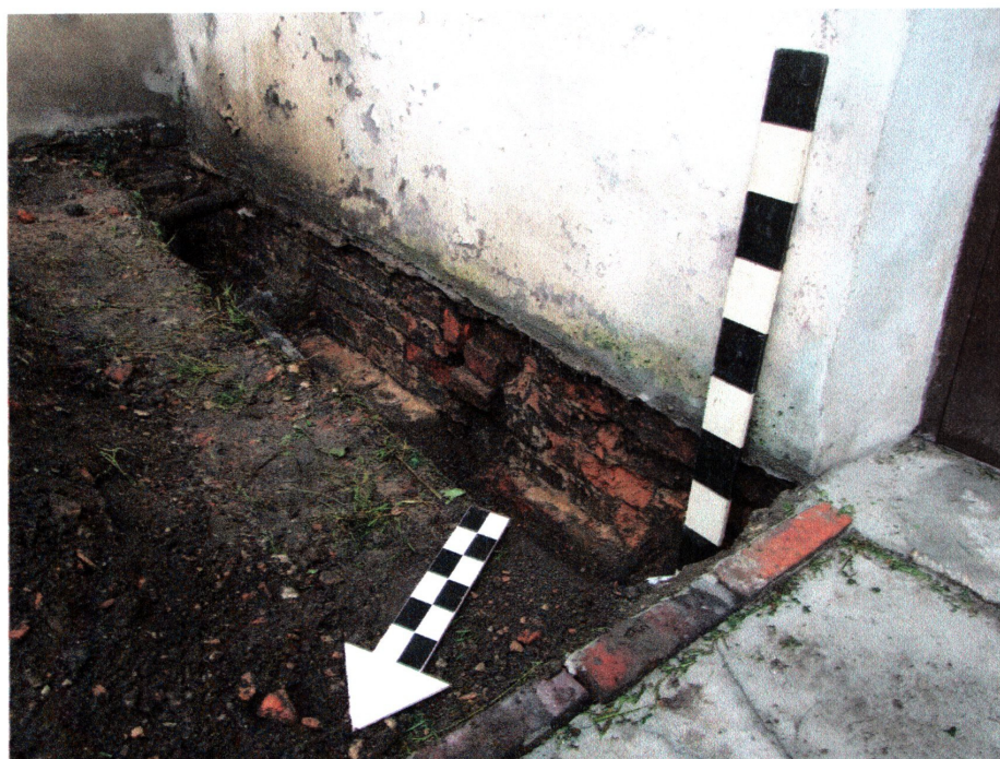
Ryc. 4. Środa Śląska, ul. Legnicka 6-8. Wykop pod osuszenie północnej ściany budynku. a, b-fundament istniejącego budynku.
