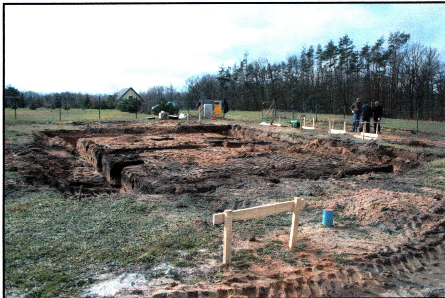
Fot. 4) Galków, gm. Miękinia dz. nr 402/17. Obszar badań po wykonaniu rowów fundamentowych. Widok z z północnego wschodu
