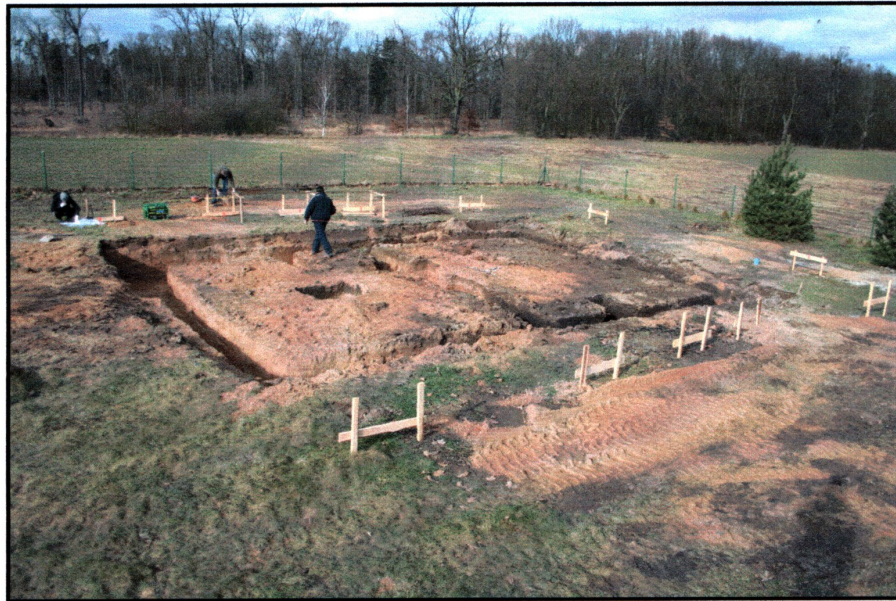
Fot. 3) Galków, gm. Miękinia dz. nr 402/17. Obszar badań po wykonaniu rowów fundamentowych. Widok z południowego wchodu
