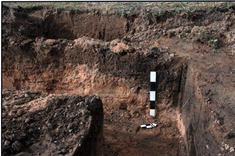
Fot. 12) Gałków, gm. Miękinia dz. nr 402/17. Wykopy fundamentowe w północno zachodnim narożniku inwestycji. Widok ze wschodu
