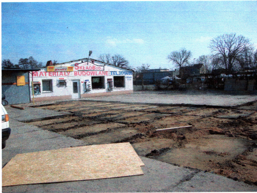
fol. 1 Widok na teren inwestycji w trakcie zdejmowania wierzchnich płyt betonowych
