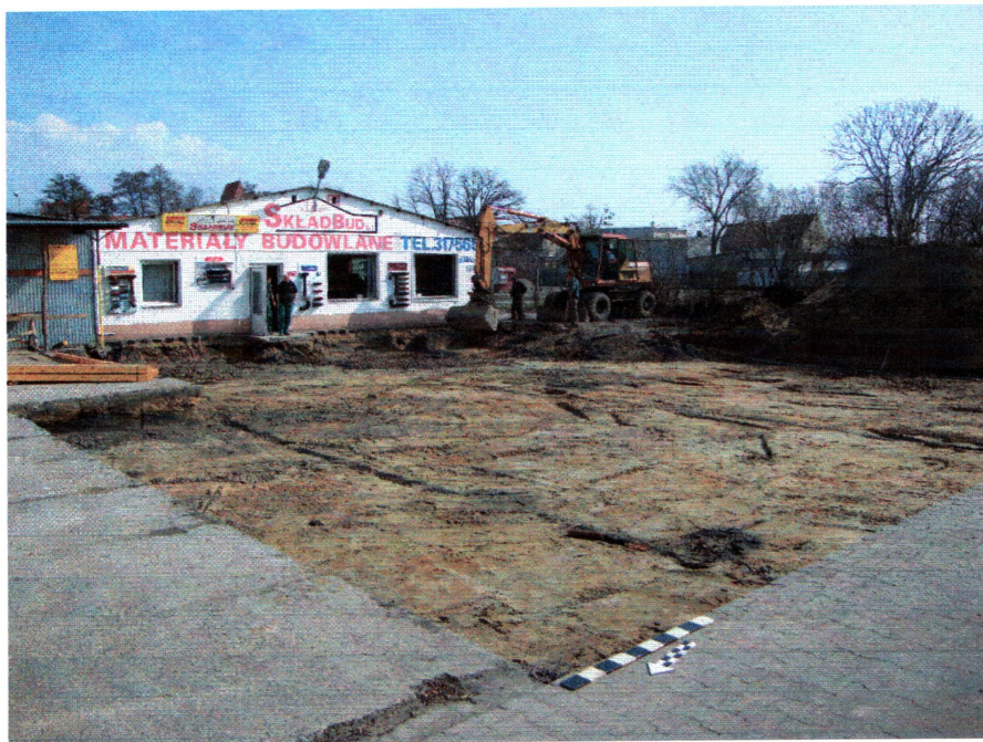
fol. 2 Widok na teren inwestycji po pogłębieniu do gł. ok. 0,5 m
