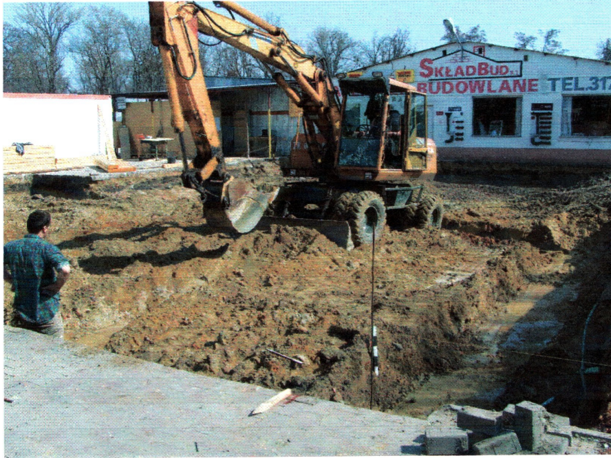
fot. 3 Nadzór archeologiczny w trakcie wykonywania wykopów pod łąwy fundamentowe
