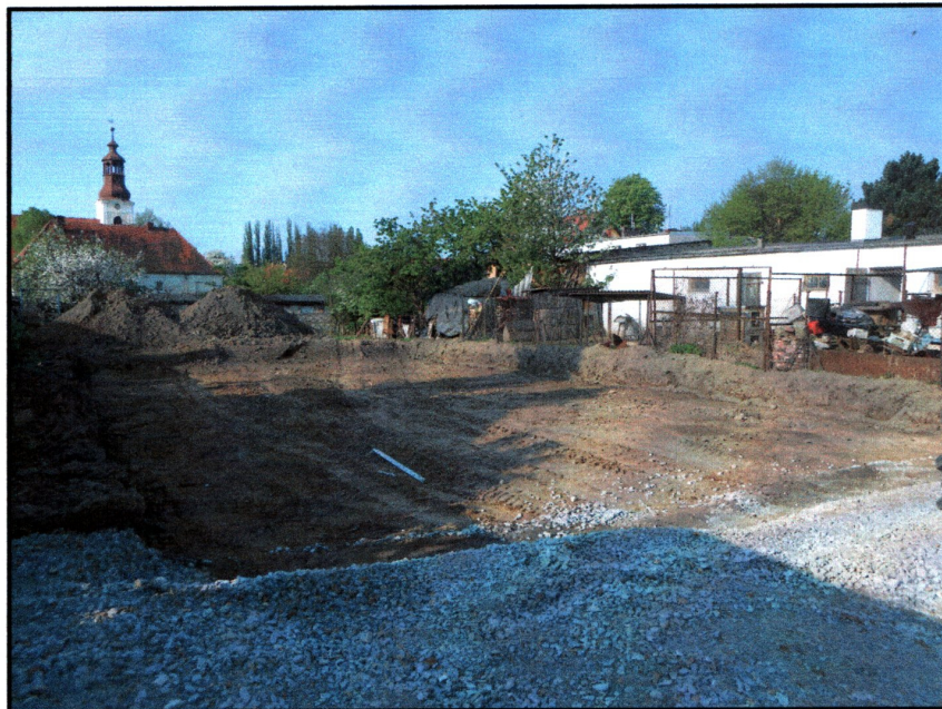
Fot. 1) Ciechów, gm. Środa Śląska dz. nr 343/5 AM-2. Wykop pod budynek mieszkalny po odhumusowaniu. Widok z północnego wschodu
