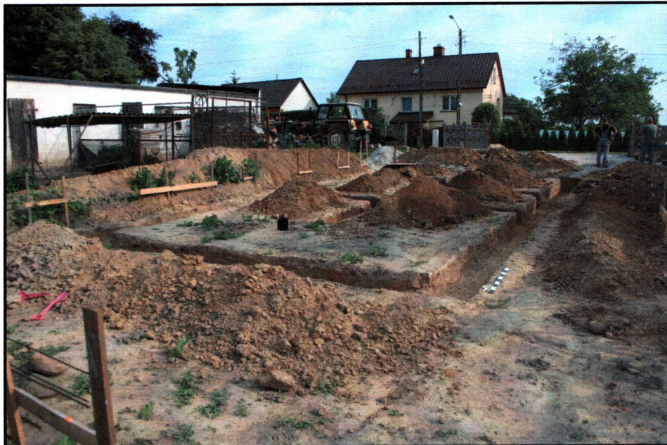
Fot. 4) Ciechów, gm. Środa Śląska dz. nr 343/5 AM-2. AM-2. Wykopy pod ławy fundamentowe. Widok z południowego-wschodu
