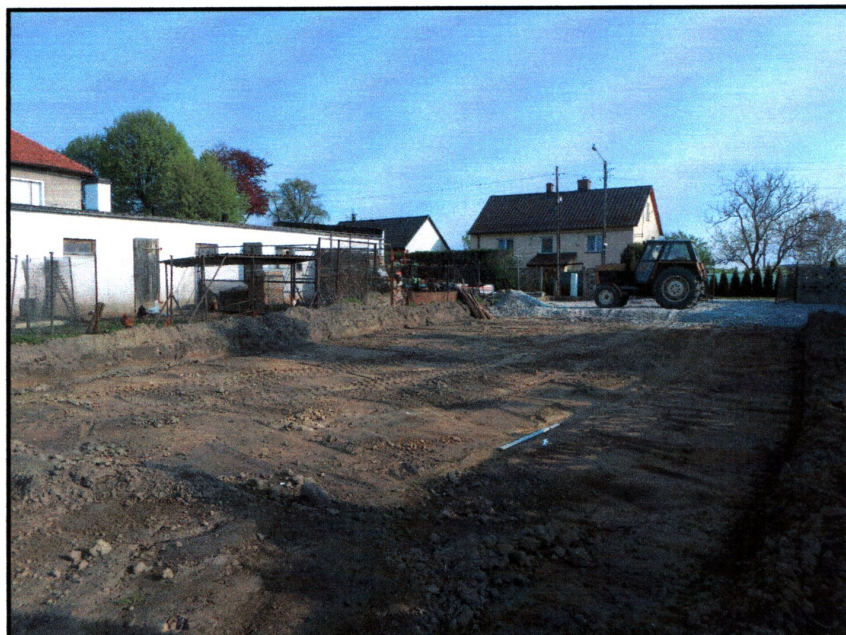
Fot. 2) Ciechów, gm. Środa Śląska dz. nr 343/5 AM-2. M-2. Wykop pod budynek mieszkalny po odhumusowaniu. Widok z południowego-wschodu
