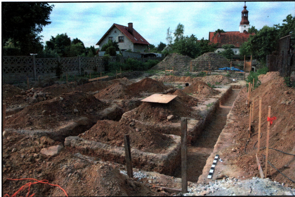
Fot. 3) Ciechów, gm. Środa Śląska dz. nr 343/5 AM-2. Wykopy pod ławy fundamentowe. Widok z północnego-zachodu
