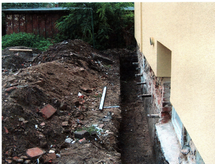
fot. 8 Wykop pod osuszenie ściany południowej budynku przy ul. Świdnickiej 18a, widok od wschodu
