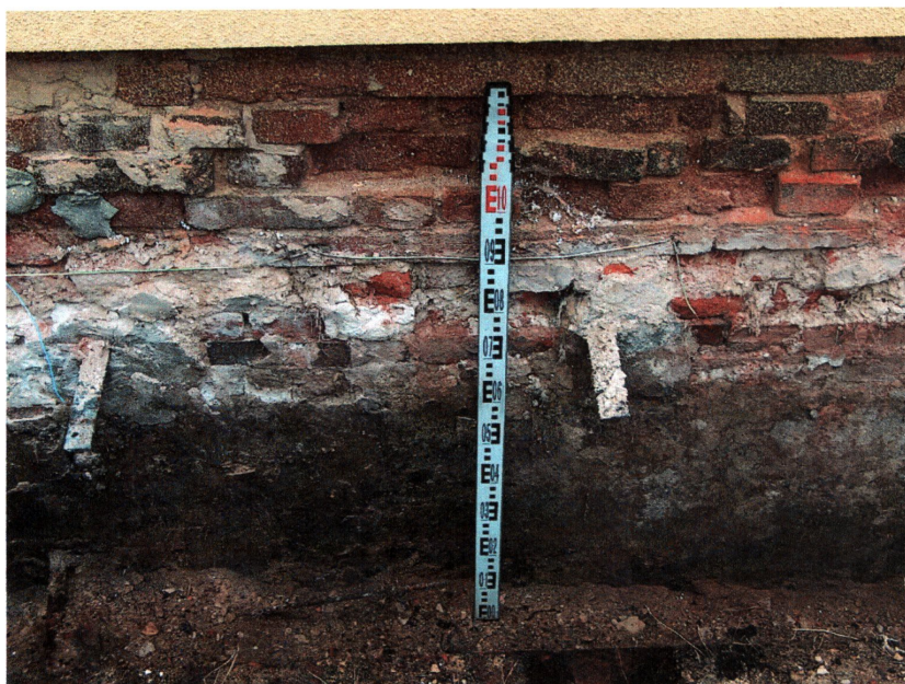
fot. 9 Fragment fundamentu południowej ściany budynku przy ul. Świdnickiej 18a, widok od południa
