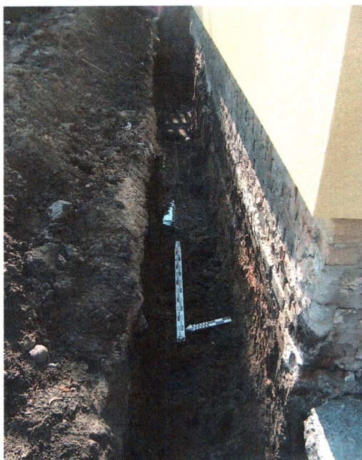
fot. 5 Wykop pod osuszenie ściany północnej budynku przy ul. Świdnickiej 18a, widok od zachodu
