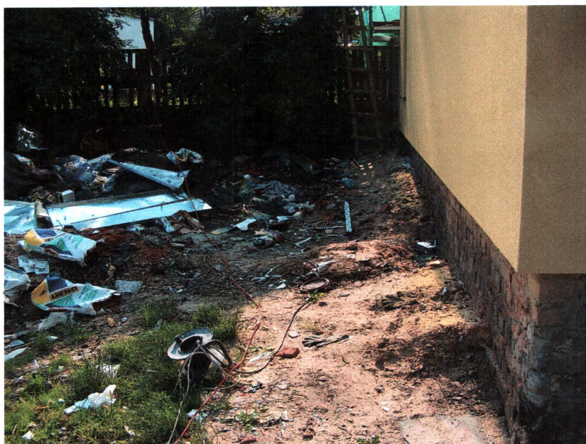
fot. 1 Przyziemie ściany północnej budynku przy ul. Świdnickiej 18a przed rozpoczęciem nadzoru, widok od zachodu
