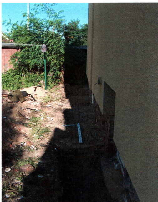
fot. 4 Przyziemie ściany południowej budynku przy ul. Świdnickiej 18a przed rozpoczęciem nadzoru, widok od wschodu
