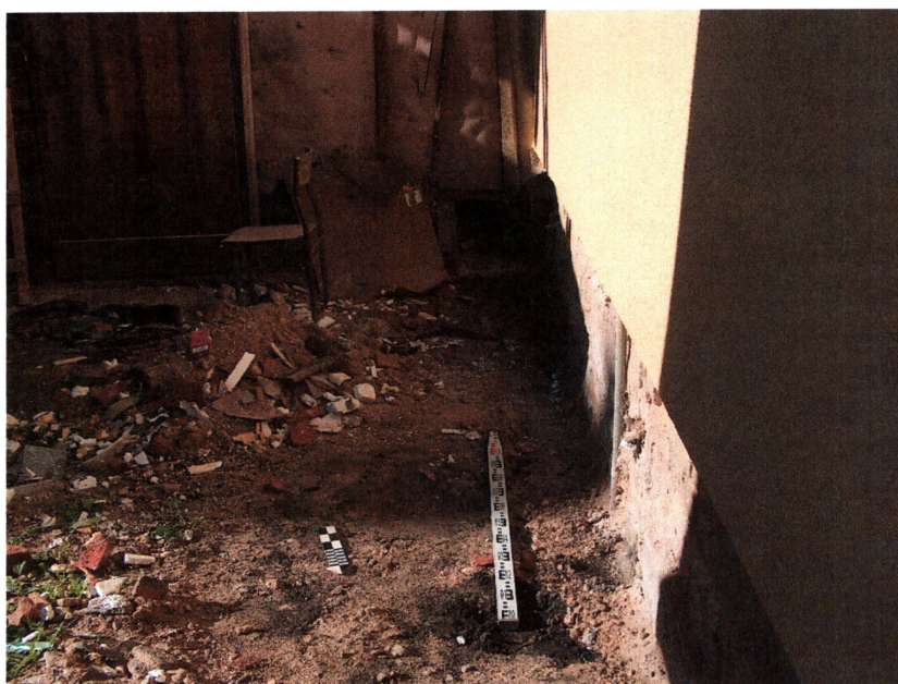
fot. 3 Przyziemie ściany wschodniej budynku przy ul. Świdnickiej 18a przed rozpoczęciem nadzoru, widok od północy
