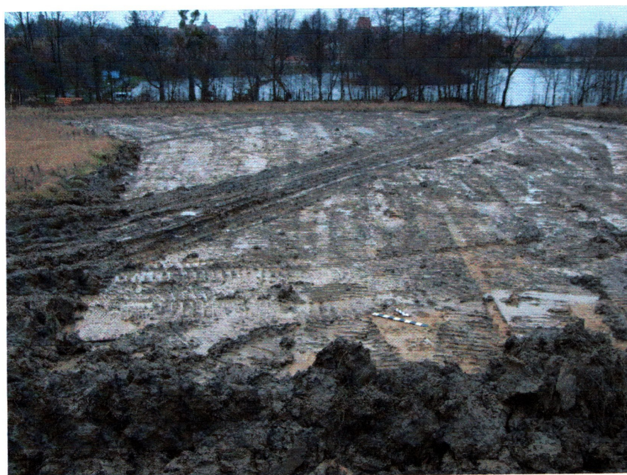
fot. 2 Teren pod budynek basenu po odhumusowaniu – widok od północy
