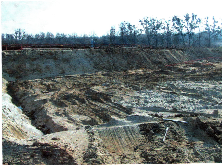
fot. 4 Wykop pod budynek basenu – widok od północy
