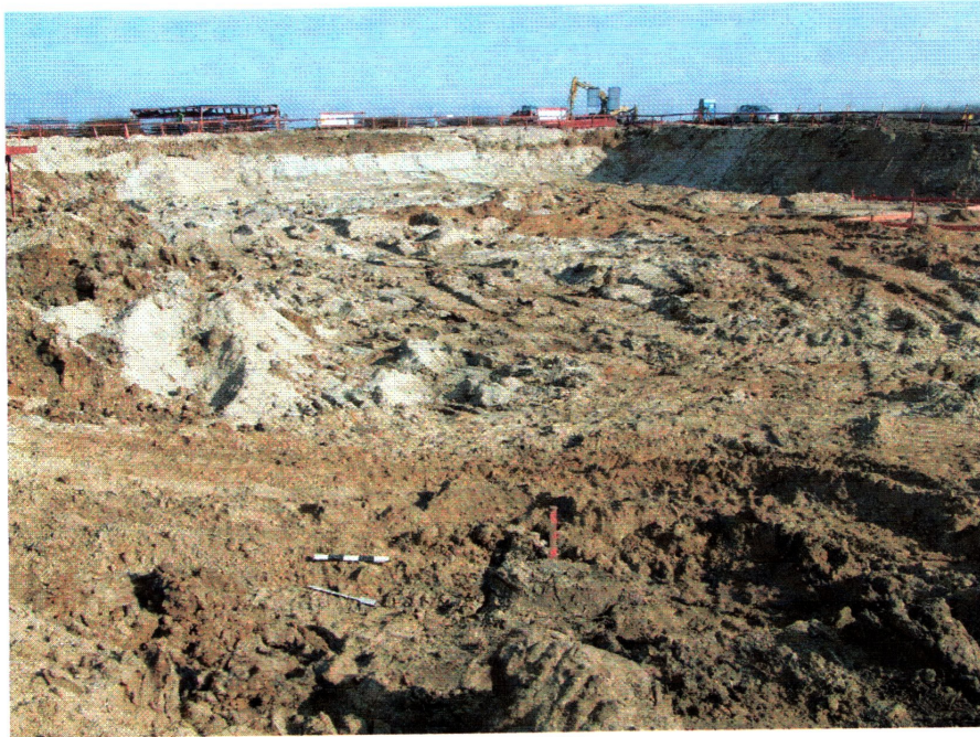
fot. 3 Wykop pod budynek basenu – widok od zachodu
