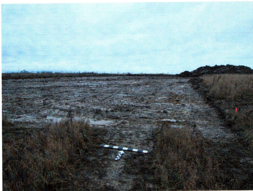
fot. 1 Teren pod budynek basenu po odhumusowaniu – widok od południa
