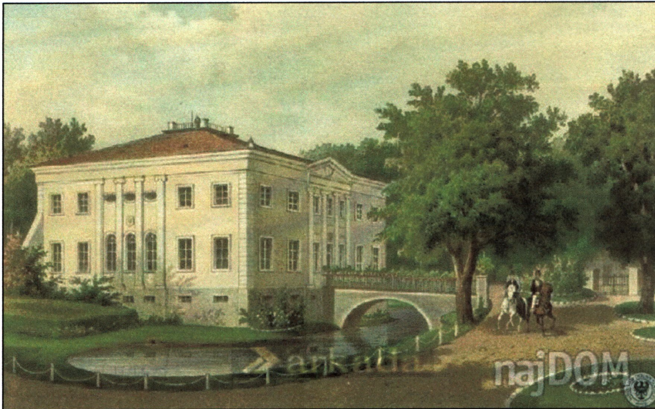
Ryc. 33. Pałac w Rakaszycach widok z SW, Duncker (1857-1883).
