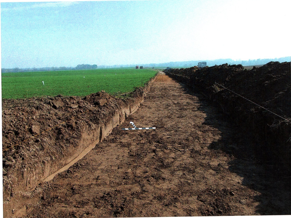
Ryc. 4. Budowa ciągu pieszo-rowerowego relacji Środa Śląska - Ciechów wzdłuż drogi powiatowej nr 2075D: a -odhumusowane partie inwestycji na odcinku A-B; b -odcinek B-C inwestycji po odhumusowaniu.
