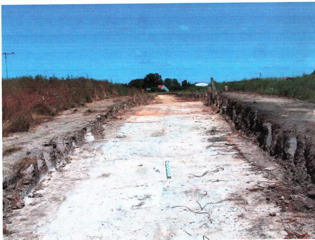
Ryc. 5. Budowa ciągu pieszo-rowerowego relacji Środa Śląska - Ciechów wzdłuż drogi powiatowej nr 2075D: a -odhumusowanie odcinka C-D inwestycji; b -odhumusowany odcinek D-E inwestycji.
