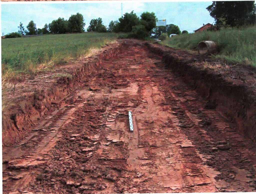
Ryc. 6. Budowa ciągu pieszo-rowerowego relacji Środa Śląska - Ciechów wzdłuż drogi powiatowej nr 2075D: a -odhumusowane partie odcinka C-D inwestycji; b -odcinek D-E po odhumusowaniu.
