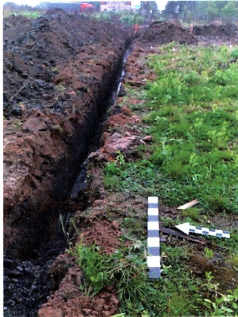
fot. 7 Widok ogólny ogólny prac na odcinku E-F-G-H
