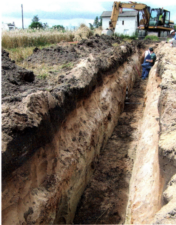
fol. 11 Widok ogólny prac na odcinku I-J
