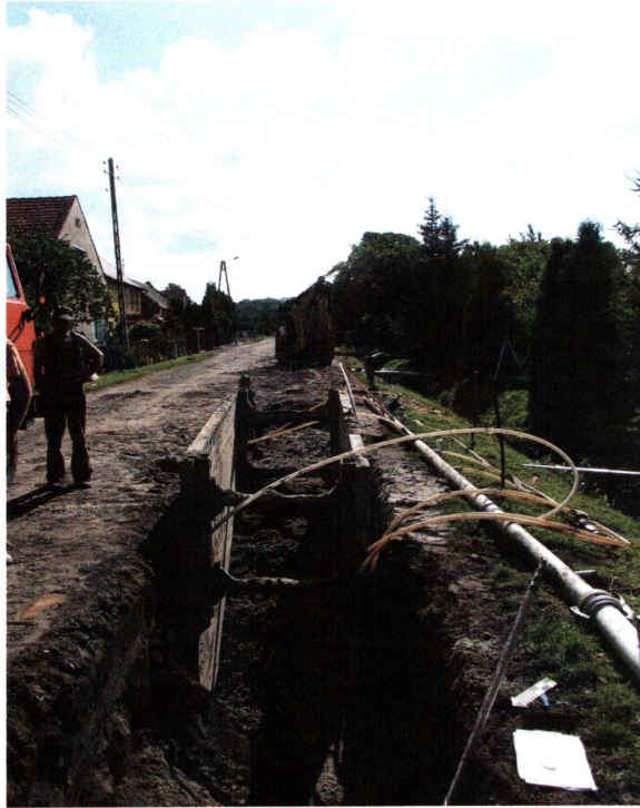
fot. 5 Widok ogólny prac na odcinku C-D-E
