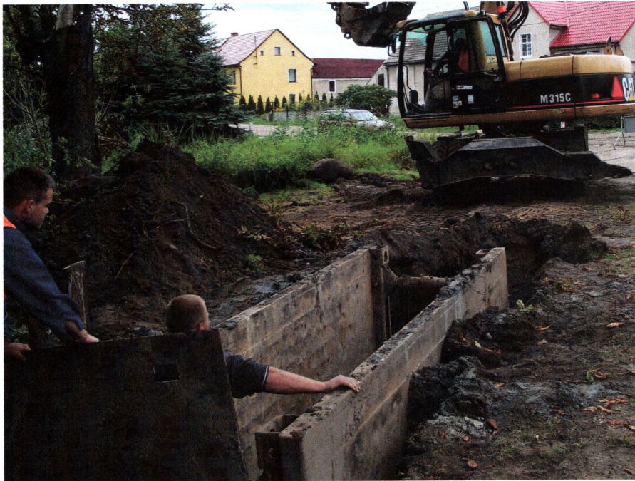
fot. 1 Widok ogólny prac na odcinku A-B
