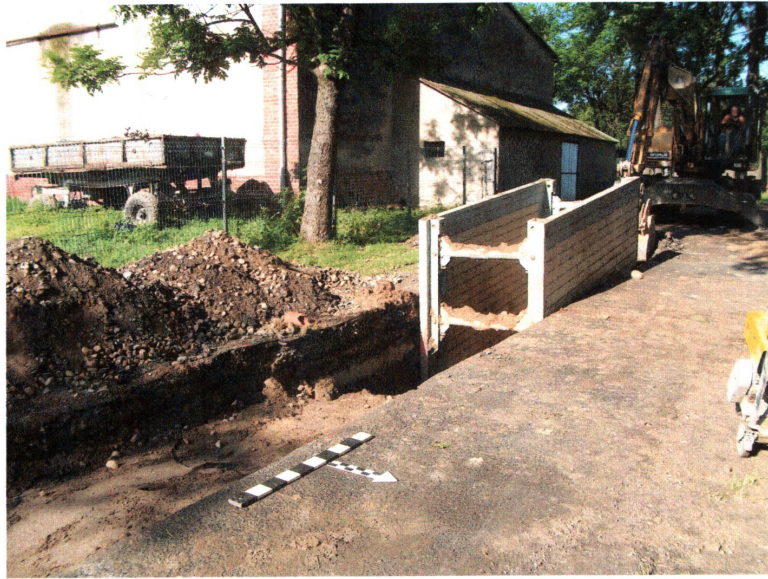
fot. 9 Widok ogólny prac na odcinku F-I
