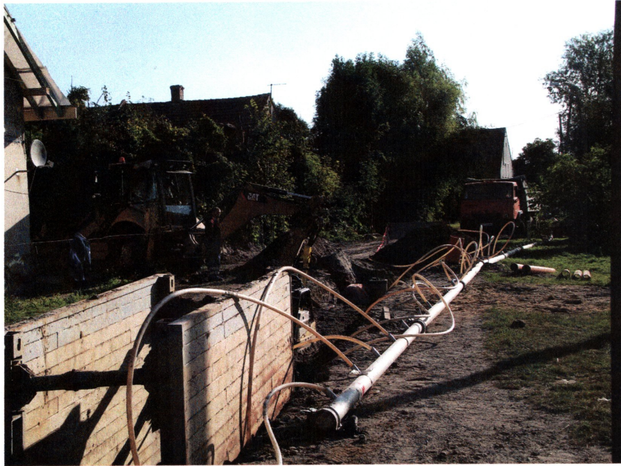
fot. 3 Widok ogólny prac na odcinku B-C
