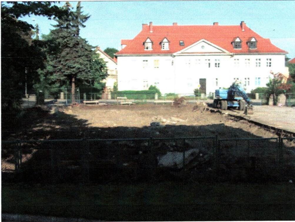
fot. 5 Teren inwestycji po pogłębieniu do około 0,5-0,7 m. Widok od strony wschodniej
