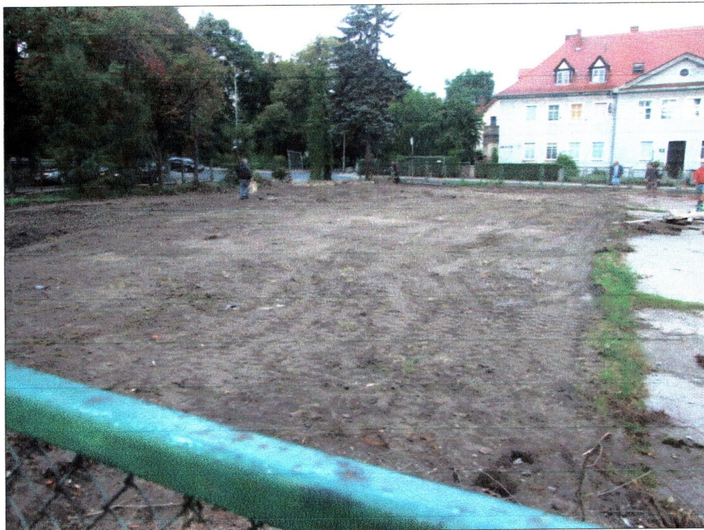
fot. 4 Teren inwestycji po zdjęciu trawnika. Widok od strony północno-wschodniej
