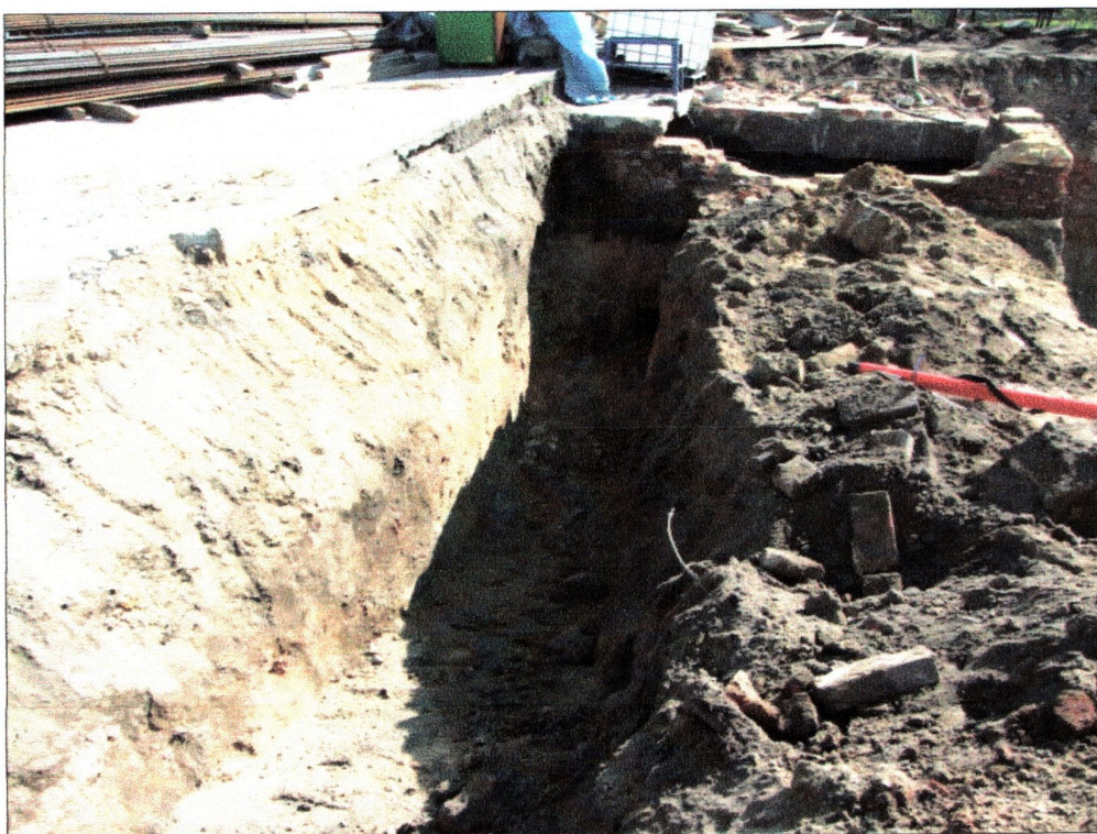
fot. 27 Wykonany sondaż VI
