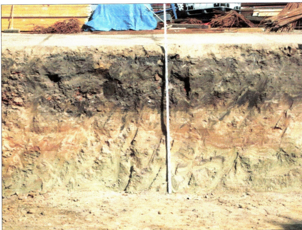
fot. 38 Profil nr 11 w północno-zachodniej części wykopu budowlanego
