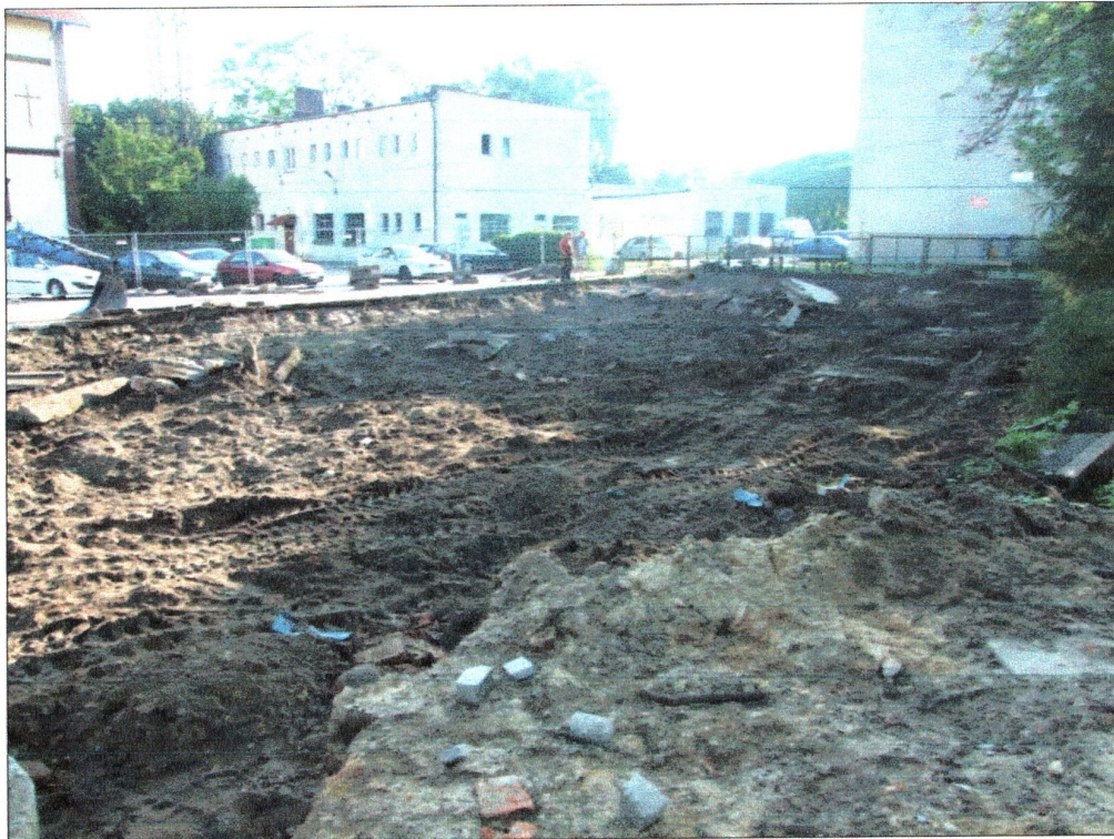
fot. 6 Teren inwestycji po pogłębieniu do około 0,5-0,7 m. Widok od strony zachodniej
