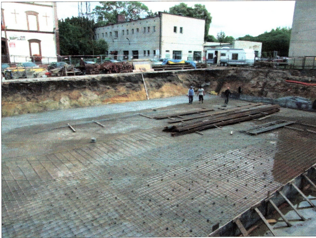
fot. 41 Zakończenie prac badawczych. Widok wykopu od strony południowej
