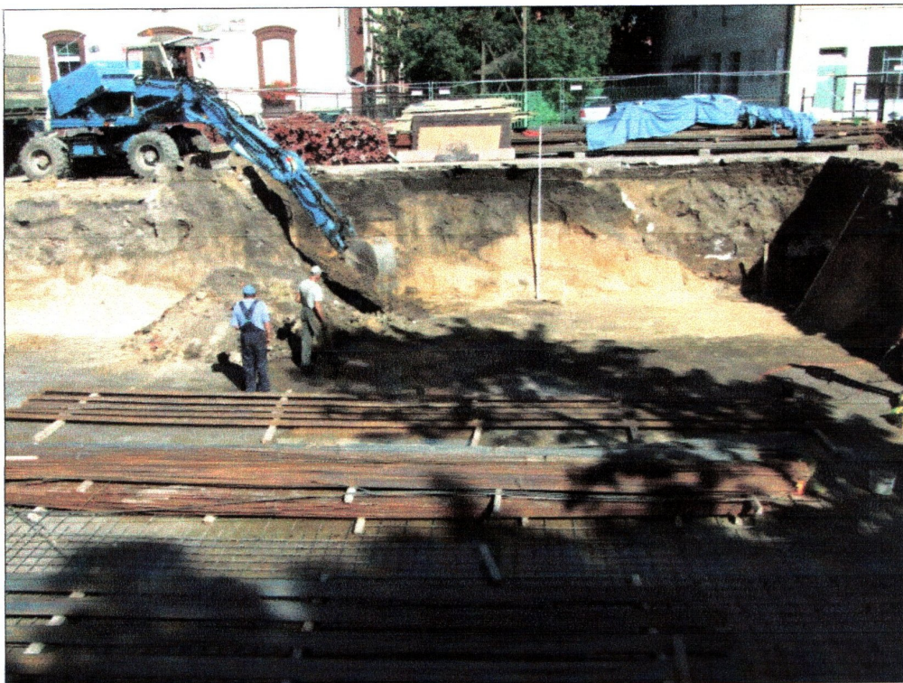
fot. 39 Nadzorowanie wykopu budowlanego w północnej części inwestycji
