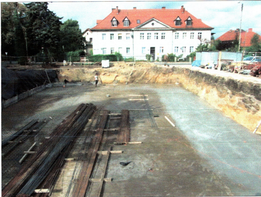
fot. 42 Zakończenie prac badawczych. Widok wykopu od strony wschodniej
