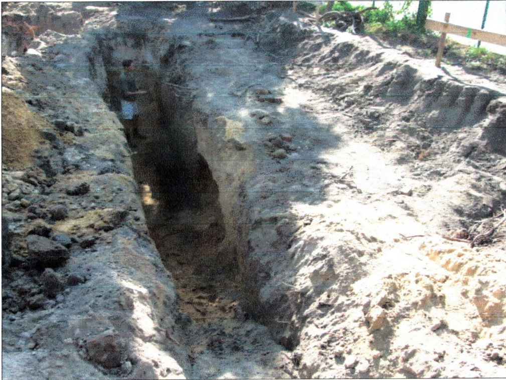
fot. 21 Doczyszczanie zachodniej ściany sondażu V
