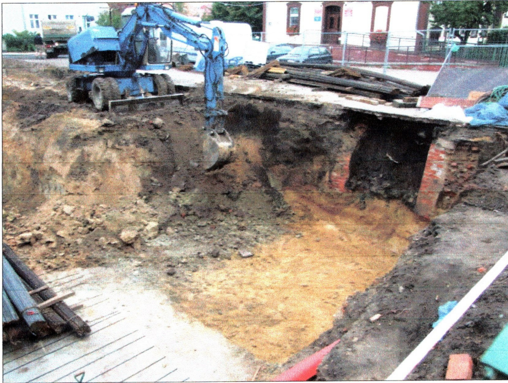
fot. 33 Nadzorowanie wykopu budowlanego w środkowej części inwestycji, w obrębie sondażu VI
