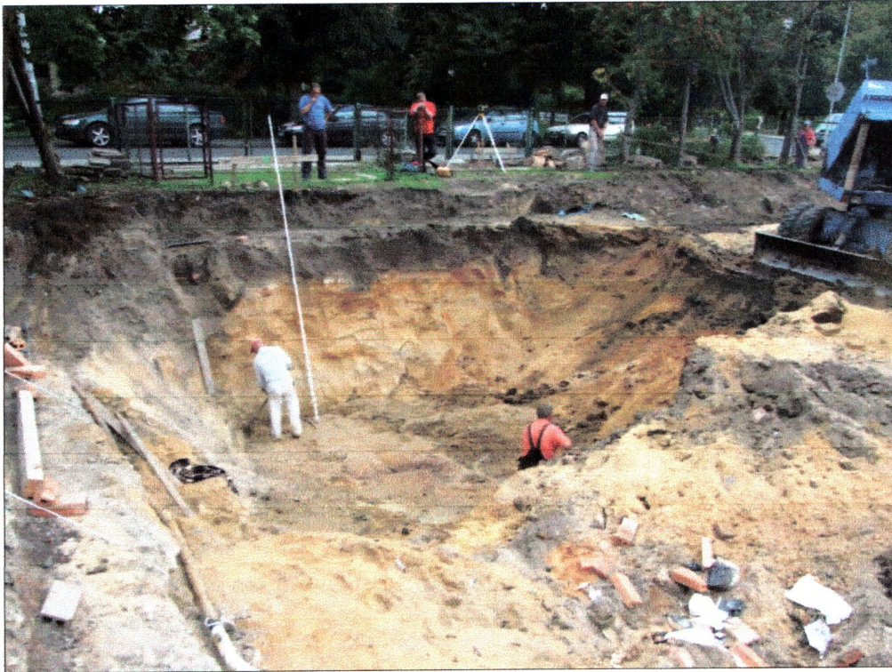
fot. 11 Nadzorowanie wykopu budowlanego w obrębie sondażu I
