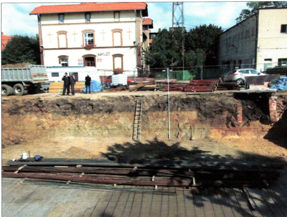
fot. 37 Profil wykopu budowlanego odsłonięty po wybraniu urobku w obrębie sondży VI-VII
