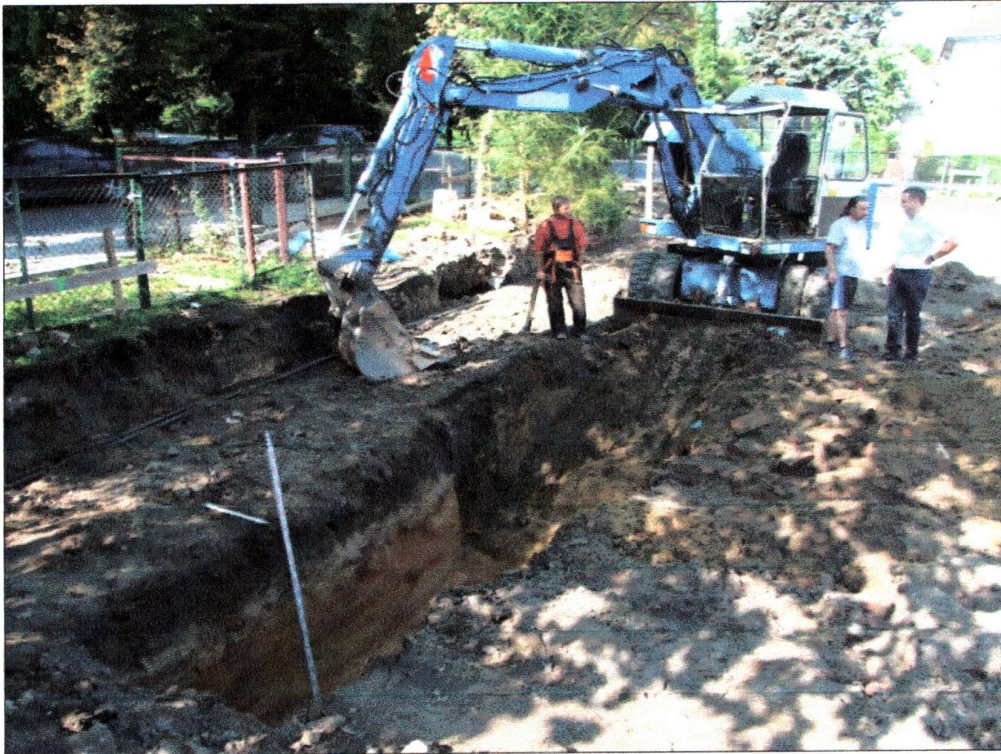
fot. 9 Widok ogólny na sondaż I po doczyszczeniu profilu
