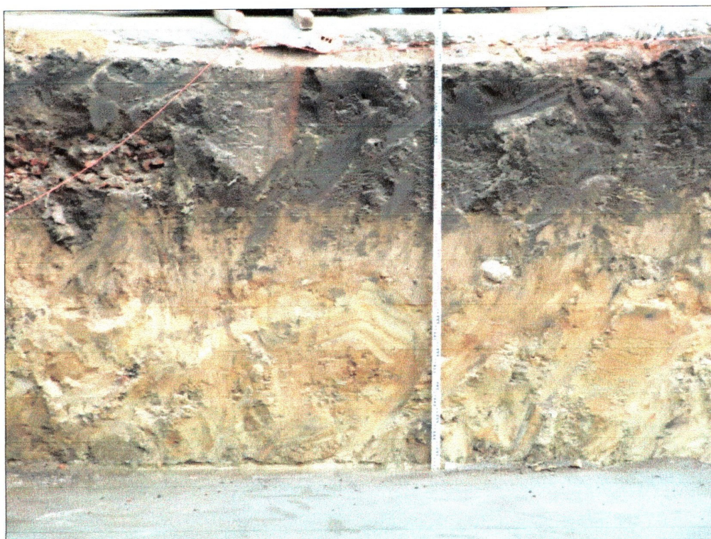
fot. 40 Fragment północnego profilu wykopu budowlanego
