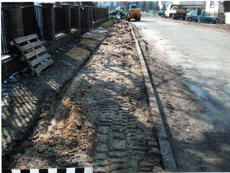
Ryc. 3. Głoska, gm. Miękinia. Budowa chodników: a -prace ziemne przy ul. Głównej, widok od południa; b -prace ziemne w rejonie skrzyżowania ul. Głównej i Krótkiej. Fot. I. Wodejko.
