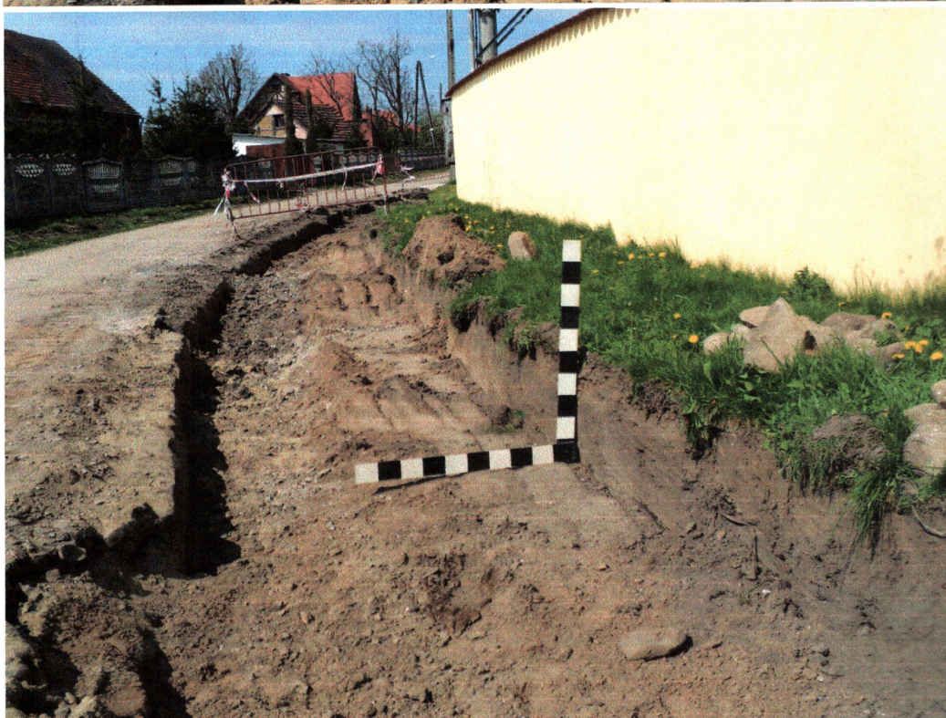
Ryc. 5. Głoska, gm. Miękinia. Budowa chodników: a -prace ziemne przy ul. Lipowej (w rejonie skrzyżowania z ul. Główną); b -korytowanie we wschodniej krawędzi ul. Lipowej, widok od południa. Fot. I. Wodejko.
