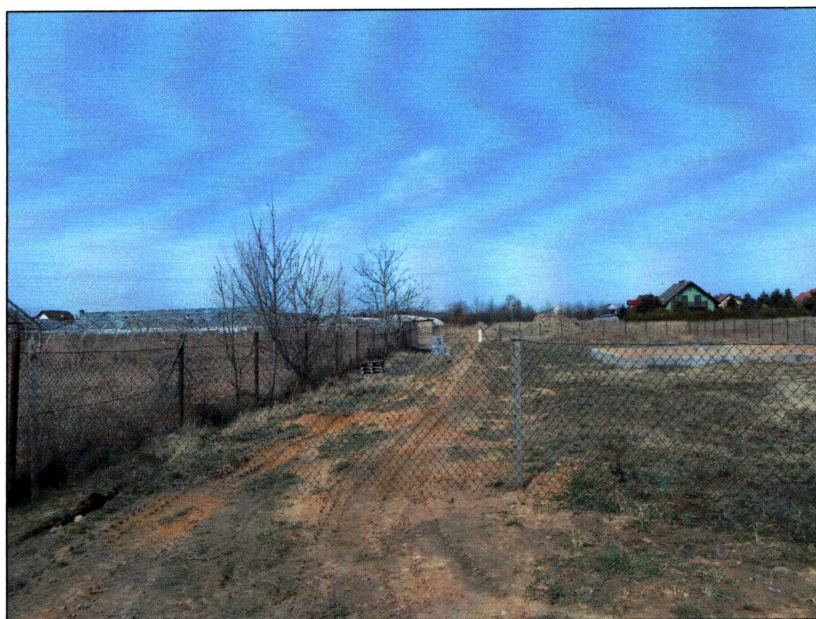
Fot. 1) Lutynia, gm. Miękinia, dz. nr 242/17. Widok z południa na obszar inwestycji
