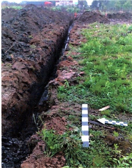
Fot. 1 Widok ogólny na środkową część wykopu przy ul. Ślężnej
