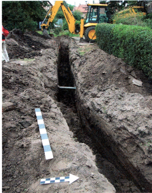
Fot. 5 Widok ogólny na środkowy fragment wykopu przy ul. Szpitalnej
