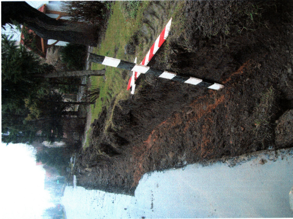
Ryc. 8. Przebudowa drogi powiatowej nr 2075D Zabłoto-Kostomłoty, gm. Kostomłoty oraz drogi powiatowej nr 2079D Kostomłoty-autostrada A4: a - korytowanie pod krawężniki jezdni miejscowości Kostomłoty; b - profil W pod studnię kanalizacji deszczowej przy ul. 1 Maja w miejscowości Kostomłoty.
