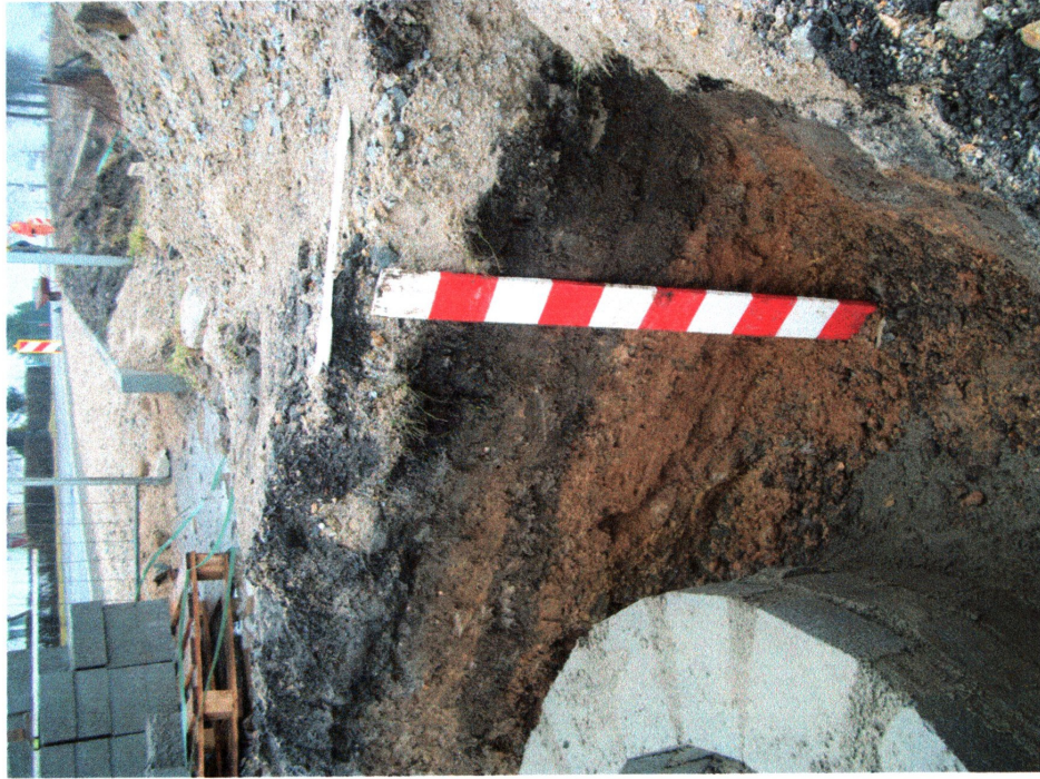
Ryc. 8. Przebudowa drogi powiatowej nr 2075D Zabłoto-Kostomłoty, gm. Kostomłoty oraz drogi powiatowej nr 2079D Kostomłoty-autostrada A4: a - korytowanie pod krawężniki jezdni miejscowości Kostomłoty; b - profil W pod studnię kanalizacji deszczowej przy ul. 1 Maja w miejscowości Kostomłoty.
