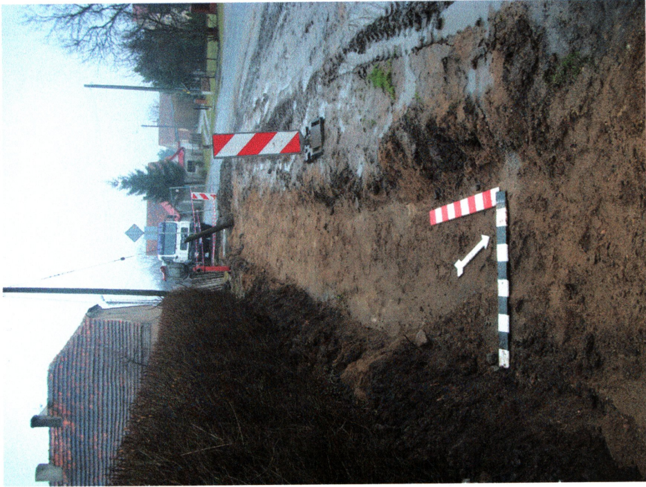
Ryc. 3. Przebudowa drogi powiatowej nr 2075D Zabłoto-Kostomłoty, gm. Kostomłoty oraz drogi powiatowej nr 2079D Kostomłoty-autostrada A4: a, b -korytowanie pod projektowane chodniki w północnej części miejscowości Zabłoto.
