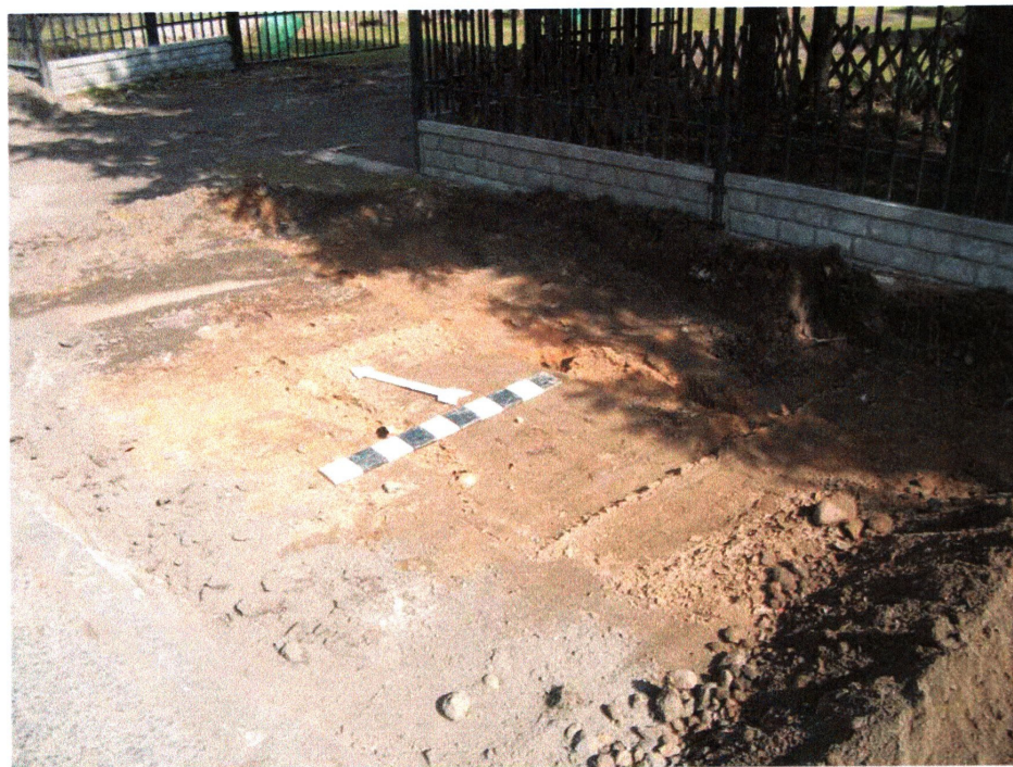
Ryc. 6. Przebudowa drogi powiatowej nr 2075D Zabłoto-Kostomłoty, gm. Kostomłoty oraz drogi powiatowej nr 2079D Kostomłoty-autostrada A4: a, b -korytowanie pod chodniki w centralnej części miejscowości Zabłoto.
