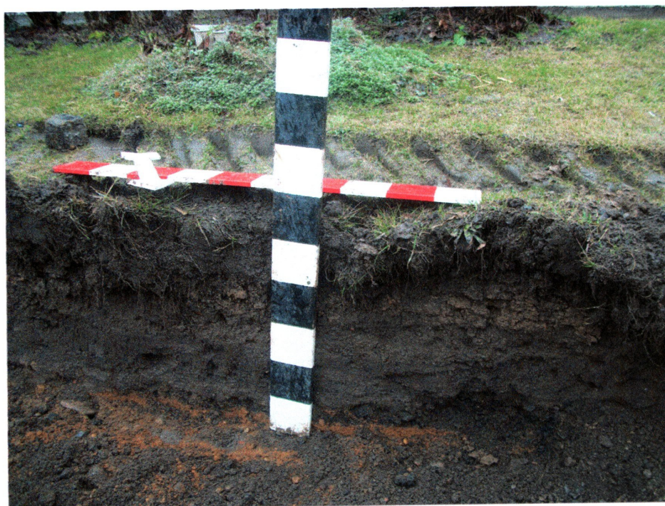
Ryc. 10. Przebudowa drogi powiatowej nr 2075D Zabłoto-Kostomłoty, gm. Kostomłoty oraz drogi powiatowej nr 2079D Kostomłoty-autostrada A4: a, b - korytowanie pod krawężniki jezdni przy ul. 1 Maja w miejscowości Kostomłoty.
