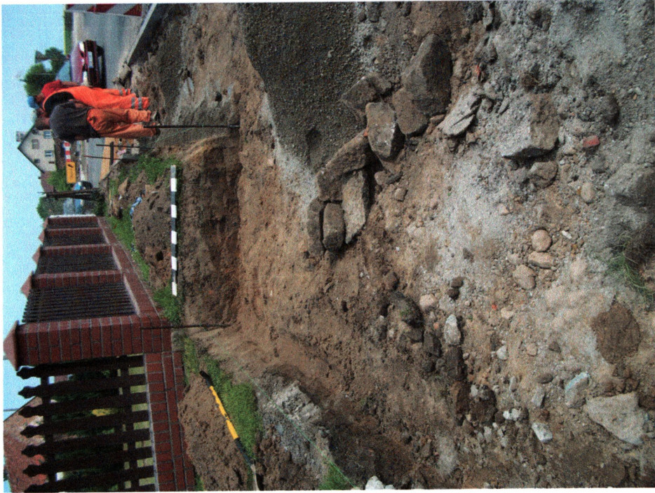
Ryc. 3. Przebudowa drogi powiatowej nr 2075D Zabłoto-Kostomłoty, gm. Kostomłoty oraz drogi powiatowej nr 2079D Kostomłoty-autostrada A4: a, b -korytowanie pod projektowane chodniki w północnej części miejscowości Zabłoto.
