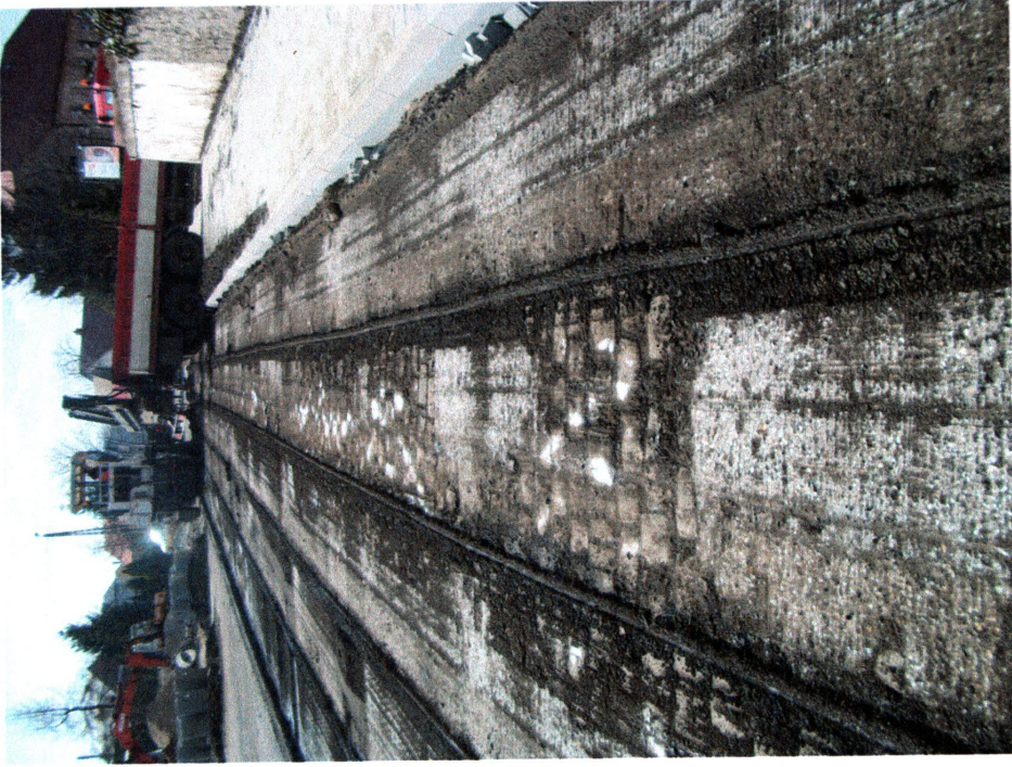
Ryc. 11. Przebudowa drogi powiatowej nr 2075D Zabłoto-Kostomłoty, gm. Kostomłoty oraz drogi powiatowej nr 2079D Kostomłoty- autostrada A4: a - profil N wykopu pod studnię kanalizacyjną na wysokości kościoła w miejscowości Kostomłoty; b - fragment zachowanego bruku z kostki granitowej w rejonie ronda przy ul. Średzkiej/1 Maja w miejscowości Kostomłoty.
