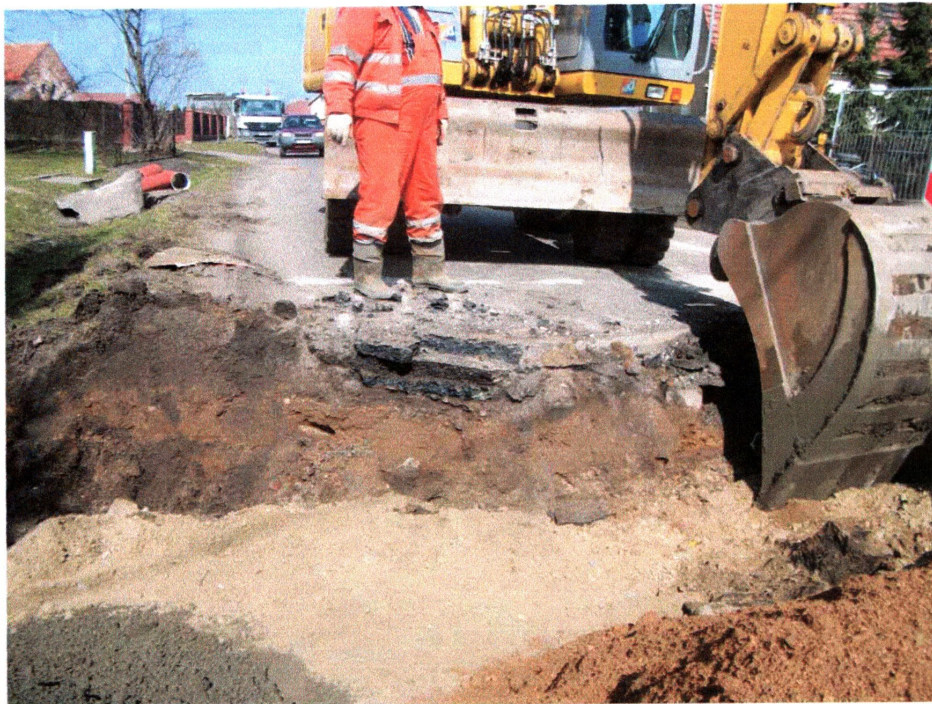
Ryc. 7. Przebudowa drogi powiatowej nr 2075D Zabłoto-Kostomłoty, gm. Kostomłoty oraz drogi powiatowej nr 2079D Kostomłoty-autostrada A4: a - profil E wykopu pod studnię S3 w miejscowości Zabłoto; b - przekrój nasypu drogowego w północnej części inwestycji w miejscowości Zabłoto.
