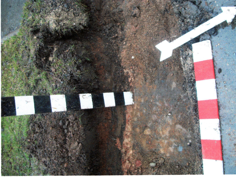
Ryc. 9. Przebudowa drogi powiatowej nr 2075D Zabłoto-Kostomłoty, gm. Kostomłoty oraz drogi powiatowej nr 2079D Kostomłoty-autostrada A4: a - korytowanie pod krawężniki jezdni w miejscowości Kostomłoty; b - fragment zachowanego bruku z drobnymi otoczaków przy ul. 1 Maja 15 w miejscowości Kostomłoty.
