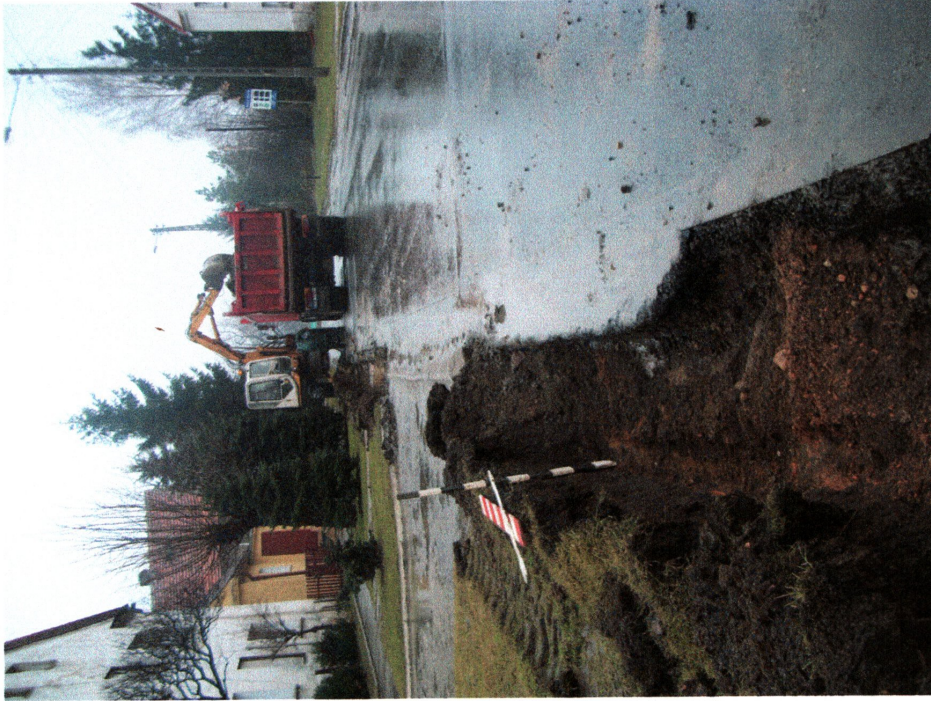
Ryc. 9. Przebudowa drogi powiatowej nr 2075D Zabłoto-Kostomłoty, gm. Kostomłoty oraz drogi powiatowej nr 2079D Kostomłoty-autostrada A4: a - korytowanie pod krawężniki jezdni w miejscowości Kostomłoty; b - fragment zachowanego bruku z drobnymi otoczaków przy ul. 1 Maja 15 w miejscowości Kostomłoty.
