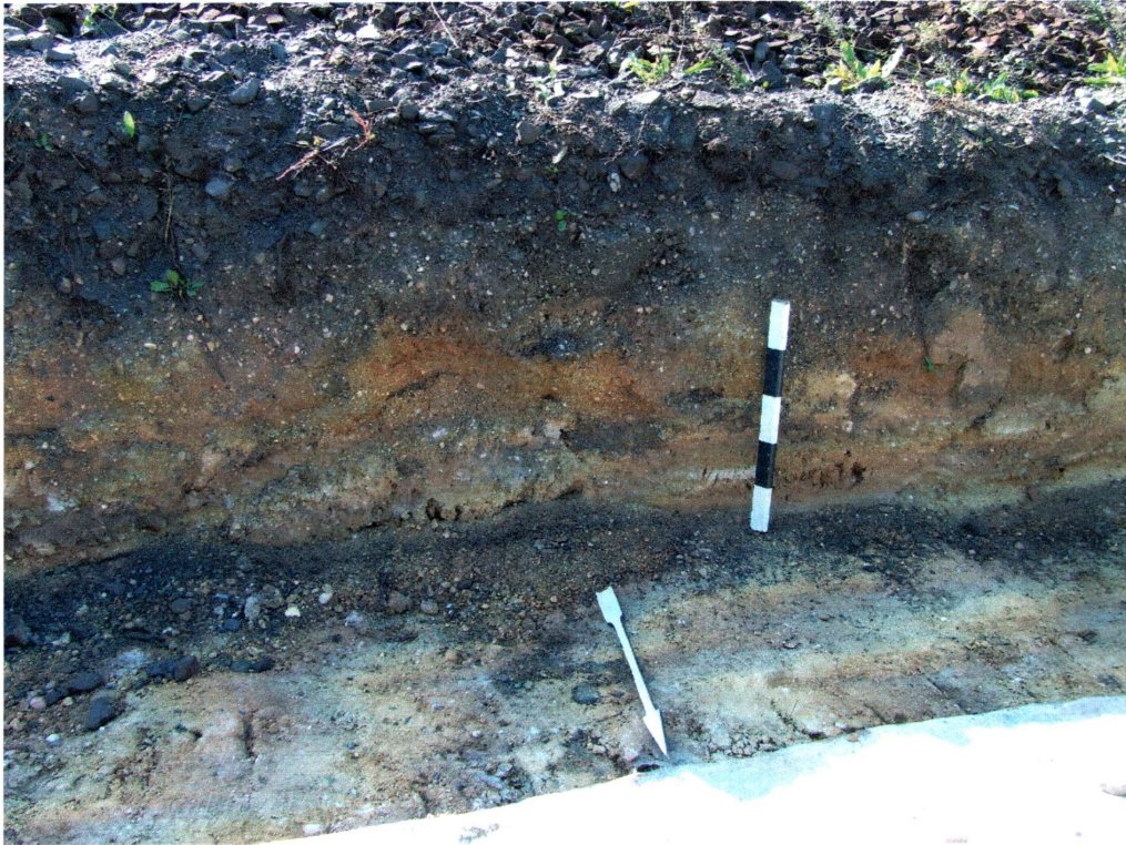
fot. 9 Prace przy wykopach pod układ torowy w zachodniej części inwestycji, na wschód od budynku stacyjnego, profil 2 (S)
