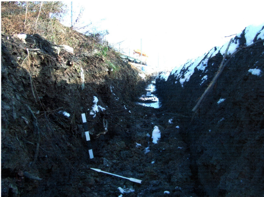
fot. 2 Fragment wykopu pod kable w zachodniej części inwestycji
