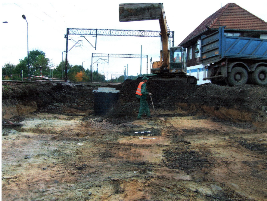
fot. 6 Prace przy wykopach pod układ torowy w środkowej części inwestycji, na wschód od budynku stacyjnego
