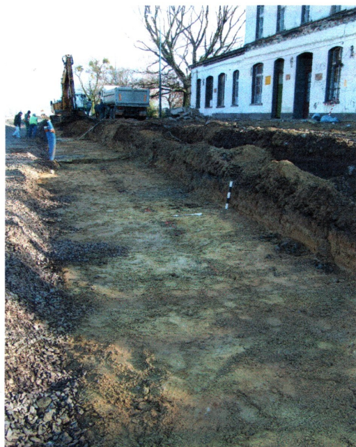
fot. 7 Prace przy wykopach pod układ torowy w środkowej części inwestycji, na wysokości budynku stacyjnego
