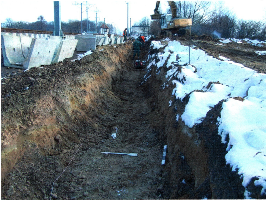
fot. 1 Fragment wykopu pod kable we wschodniej części inwestycji
