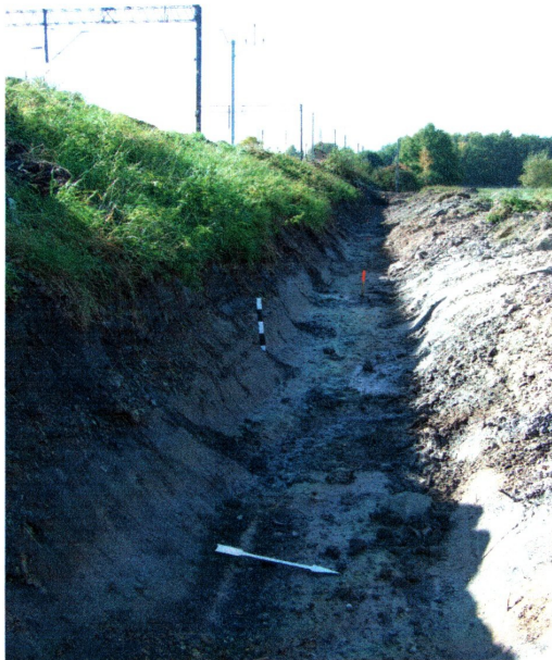
fot. 3 Fragment wykopu pod odwodnienie w północno-zachodniej części inwestycji
