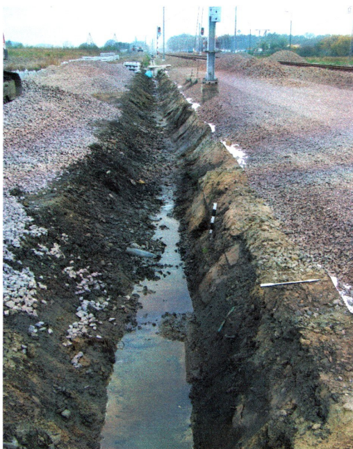
fot. 4 Fragment wykopu pod odwodnienie w południowo-wschodniej części inwestycji
