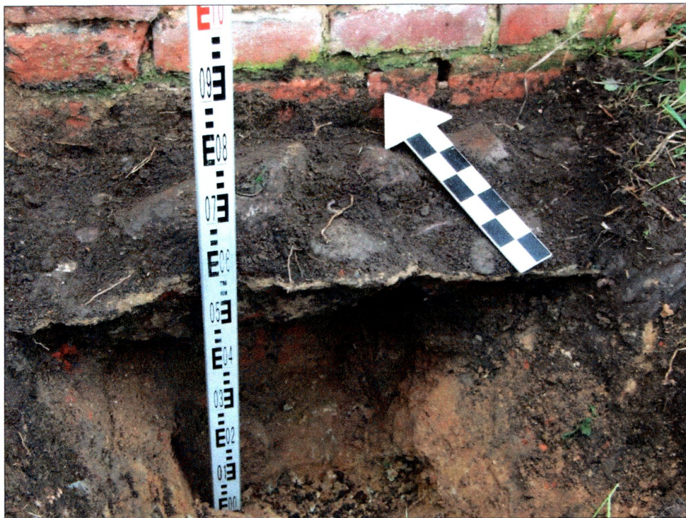
fot. 4 Profil N wykopu sondażowego B
