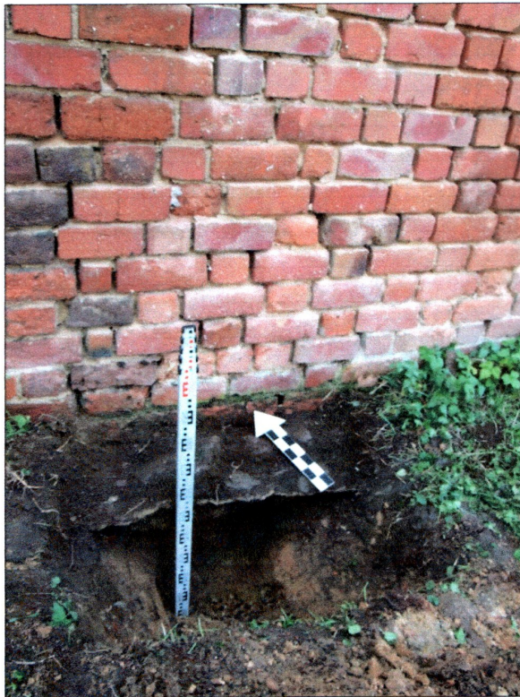
fot. 3 Wykop sondażowy B
