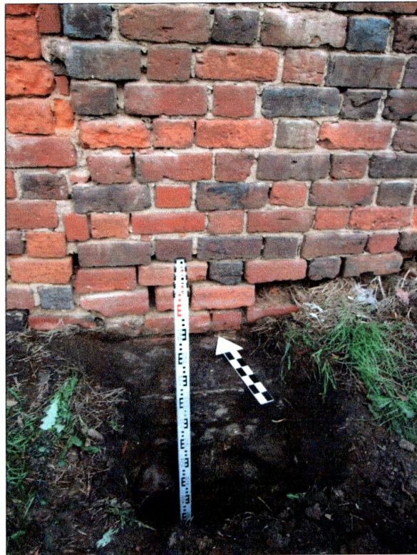
fot. 1 Wykop sondażowy A
