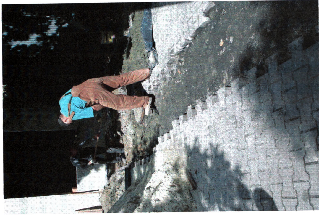
Ryc. 4. Środa Śląska, ul. Św. Andrzeja, dz. nr 80 AM 16. Przebudowa (adaptacja) garaży na pracownie kształcenia zawodowego. Prace ziemne przy wykopach liniowych pod instalacje techniczne.
