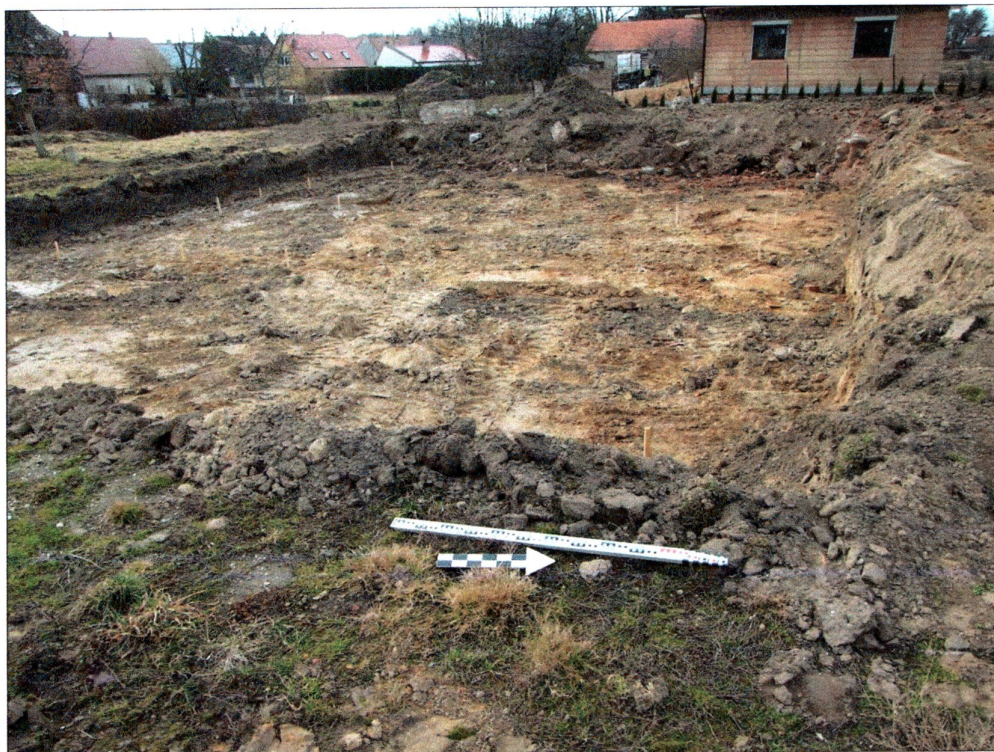
fot. 4 Wykop pod budynek mieszkalny, widok od strony wschodniej
