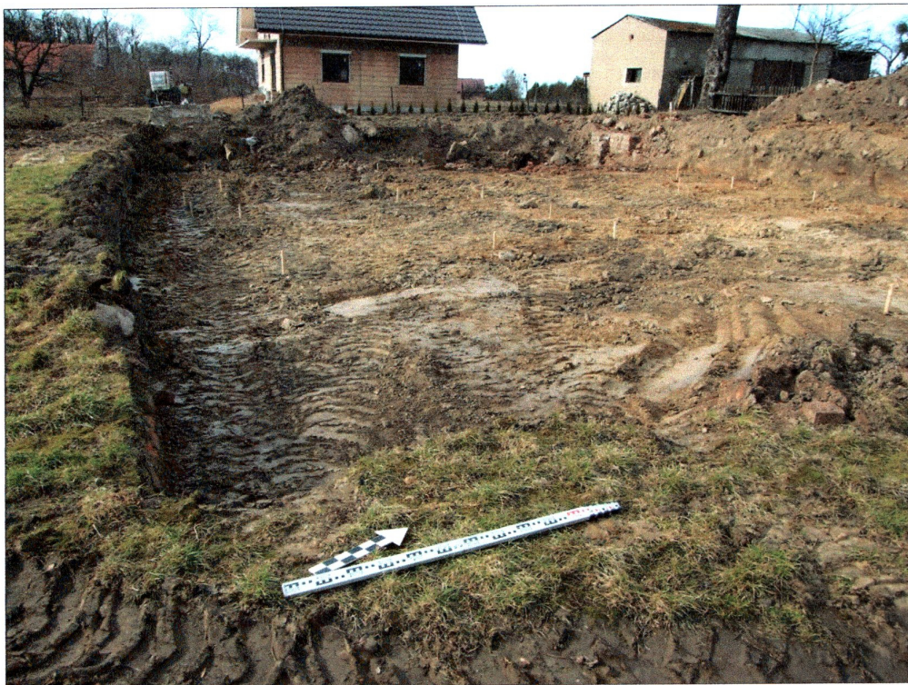
fot. 2 Wykop pod budynek mieszkalny, widok od strony południowo-wschodniej
