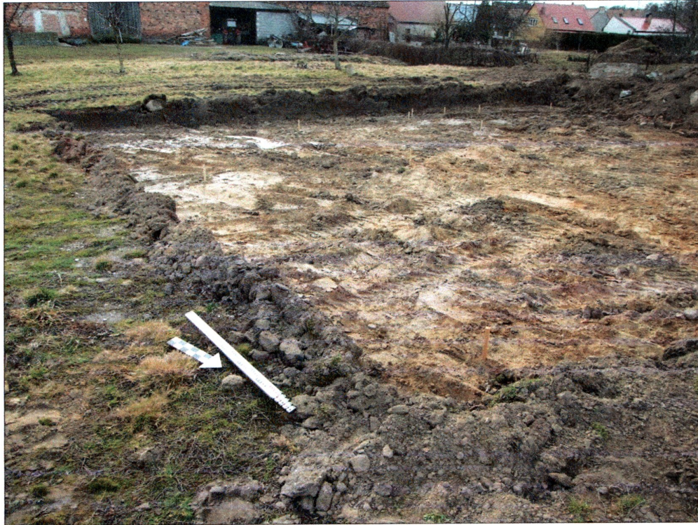
fot. 3 Wykop pod budynek mieszkalny, widok od strony północno-wschodniej
