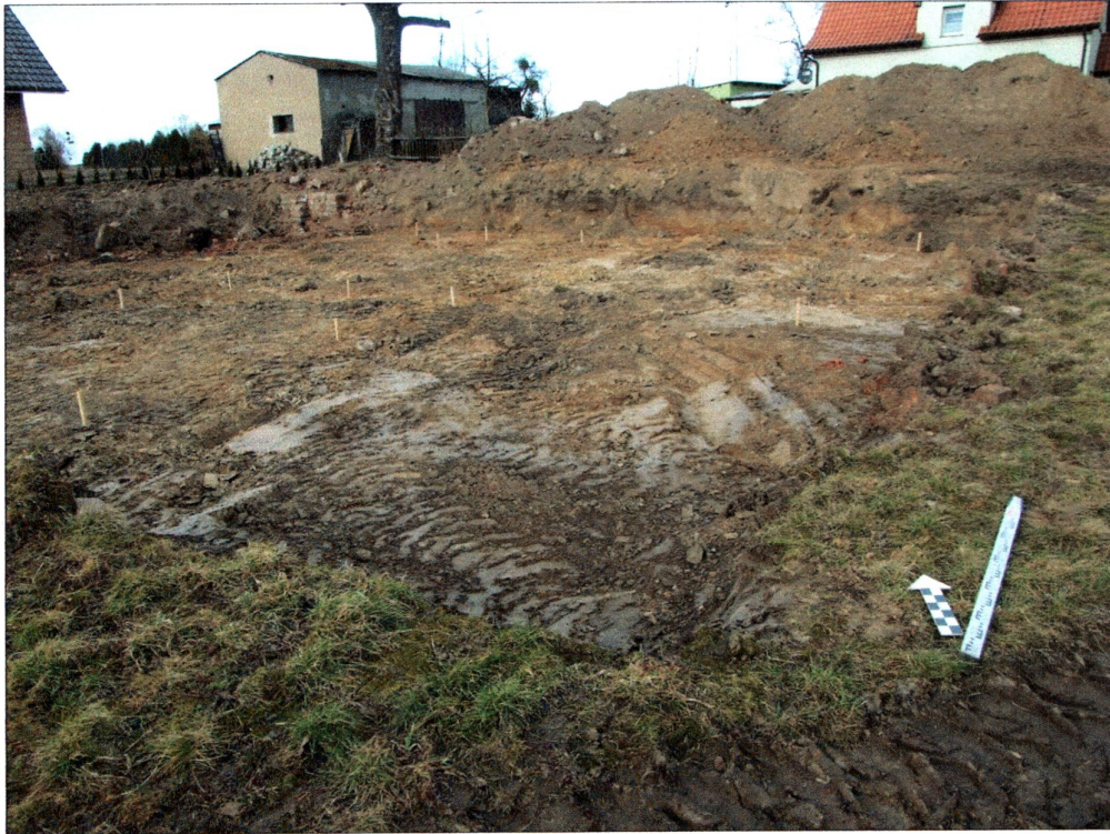
fot. 1 Wykop pod budynek mieszkalny, widok od strony południowej
