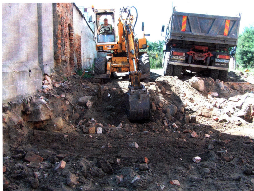
il. 21 Zdejmowanie wierzchniej warstwy nadkładu w południowo-wschodniej części działki
