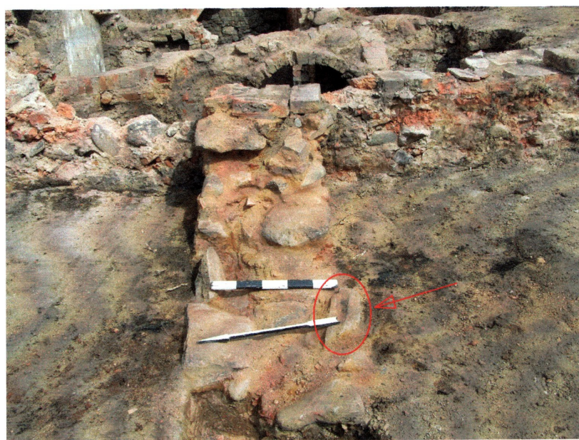
il. 50 Relikty południowego fundamentu oficyny z zaznaczonym wtórnym użytym fragmentem piaskowcowego ościeża
