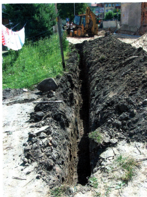
il. 69 Wykop pod przyłącze gazowe, widok od strony zachodniej
