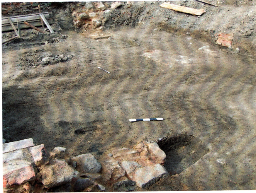
il. 53 Relikty fundamentowania budynku gospodarczego (faza IVa)
