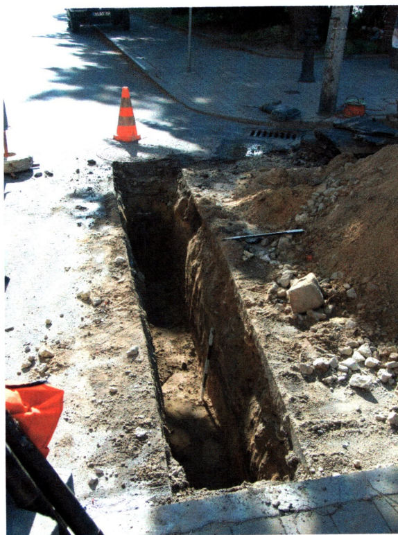
il. 66 Wykop pod przyłącze deszczowe, widok ogólny od strony zachodniej
