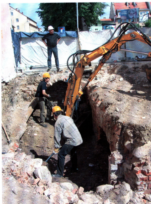
il. 17 Odgruzowywanie piwnic w północno-wschodnim narożniku działki
