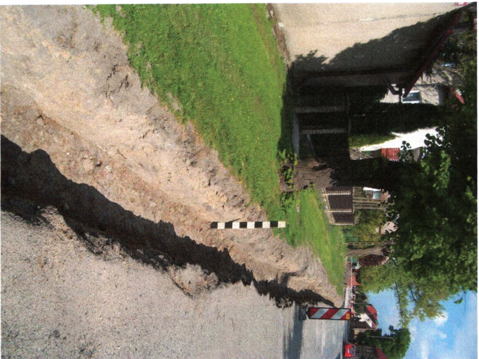
Ryc. 4. Budowa chodników i ścieżek rowerowych w m. Gałów: a-profil północny w rejonie ul. Słonecznej (korytowanie pod krawężniki); b-profil południowy w rejonie ul. Wrocławskiej (korytowanie pod krawężniki).
