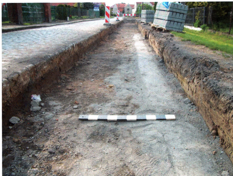
Ryc. 3. Budowa chodników i ścieżek rowerowych w m. Gałów: a, b-korytowanie pod chodniki i ścieżkę rowerową-ul. Słoneczna.
