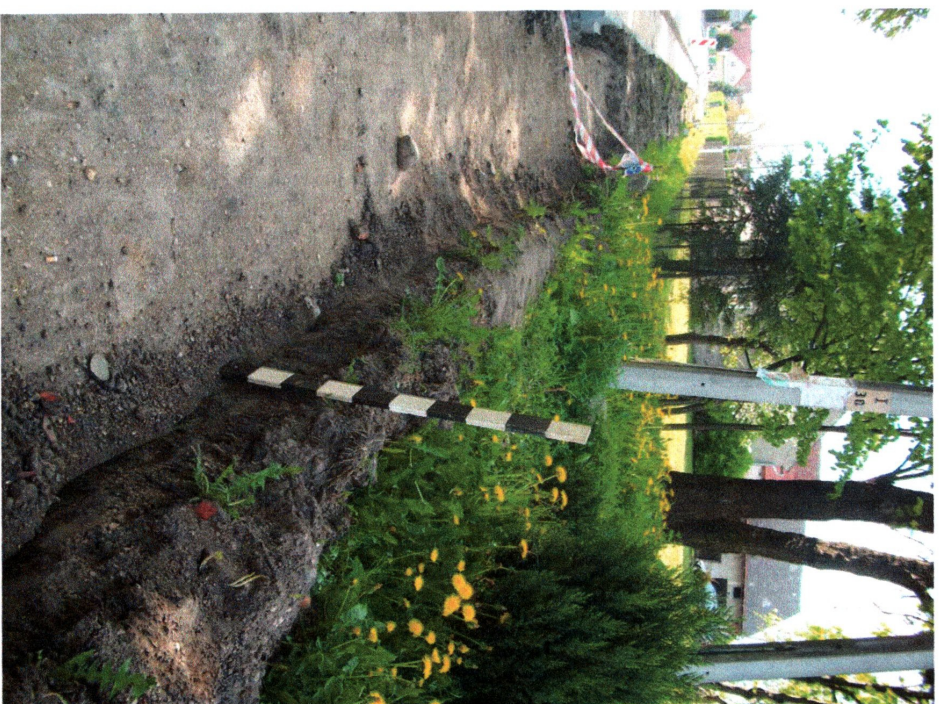
Ryc. 2. Budowa chodników i ścieżek rowerowych w m. Gatów: a-profil południowy korytowania pod ścieżkę rowerową na wysokości kościoła; b-profil północny korytowania pod ścieżkę rowerową na wysokości kościoła.
