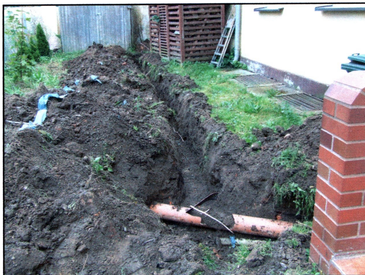
Fot. 3. Kryniczno, gm. Środa Śląska dz. nr 414. Odgałęzienie wykopu w kierunku zachodnim w środkowej części wykopu głównego. Widok z zachodu
