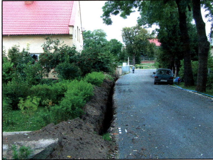
Fot. 1. Kryniczno, gm. Środa Śląska dz. nr 414. Południowa część wykopów. Widok z południa
