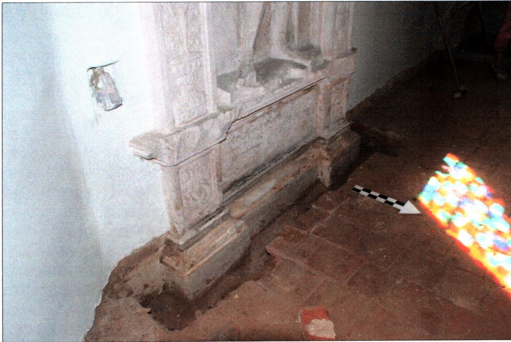
fot. 11 Piotrowice, gm. Kostomłoty. Kościół pw. Św. Katarzyny – sondaż przy pomniku nagrobnym Conrada Nimitza
