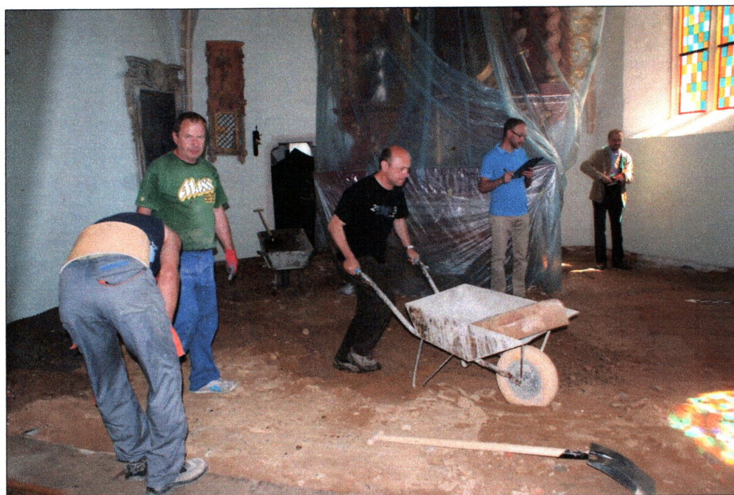
fot. 4 Piotrowice, gm. Kostomłoty. Prace związane z wymianą posadzki w prezbiterium kościoła pw. Św. Katarzyny
