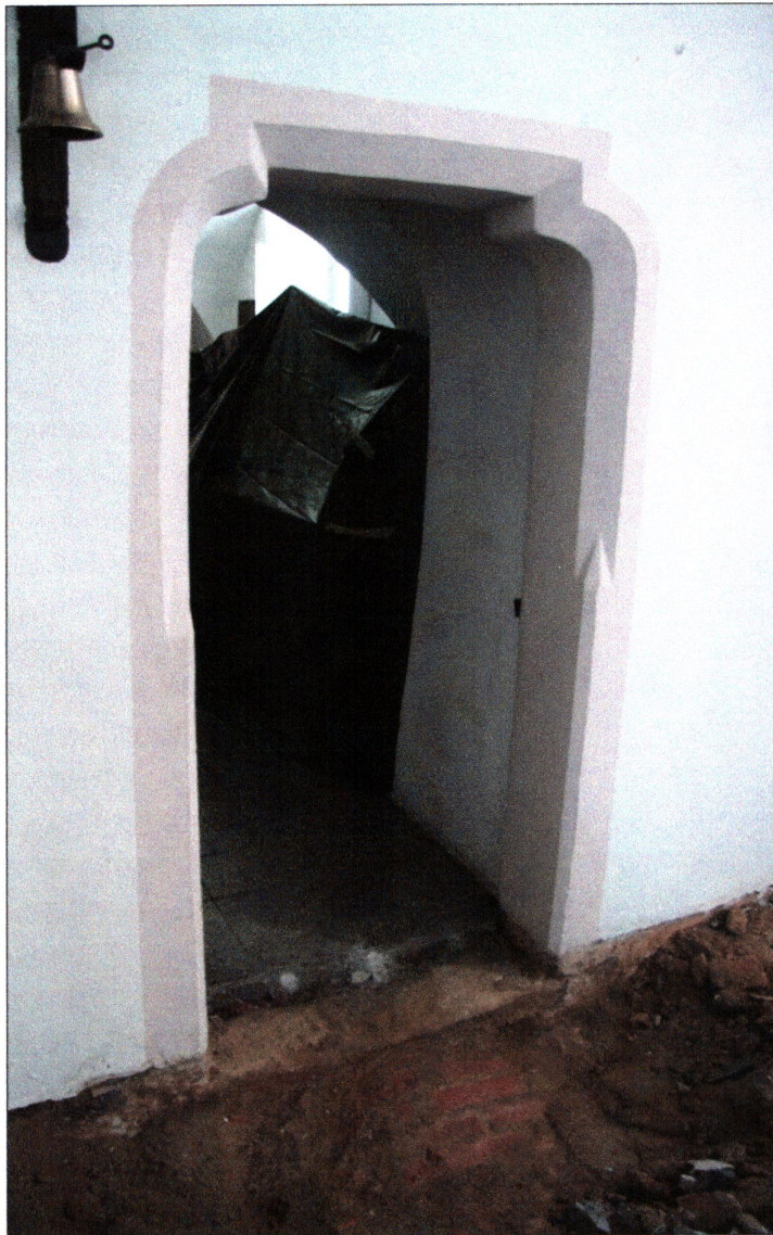
fol. 8 Piotrowice, gm. Kostomłoty. Wnętrze prezbiterium – portal obecnej zakrystii kościoła pw. Św. Katarzyny
