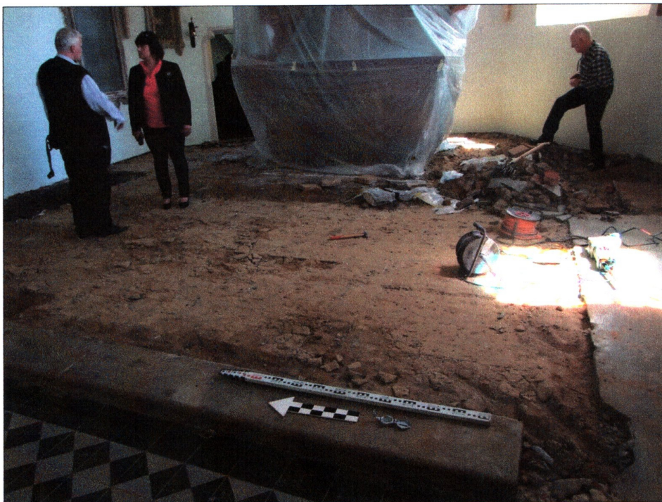
fol. 6 Piotrowice, gm. Kostomłoty. Południowa część prezbiterium kościoła pw. Św. Katarzyny po zdjęciu współczesnej posadzki.
