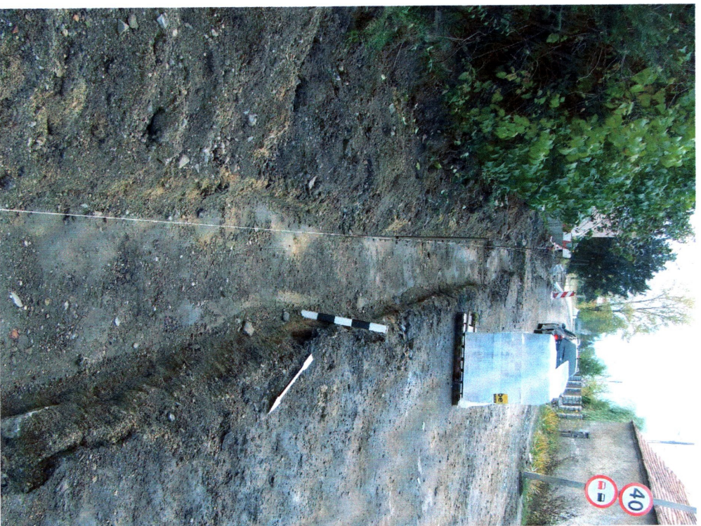
Ryc. 4. Udanie, gm. Ioco. Przebudowa chodnika wraz ze skrzyżowaniem w ciągu dróg powiatowych nr 2078 D i 2091 D (dz. nr 261, 287, i 264): a - skorytowany obszar pod projektowane chodniki w części NW inwestycji; b - widok na części SE inwestycji podczas osadzania studzienki kanalizacyjnej.
