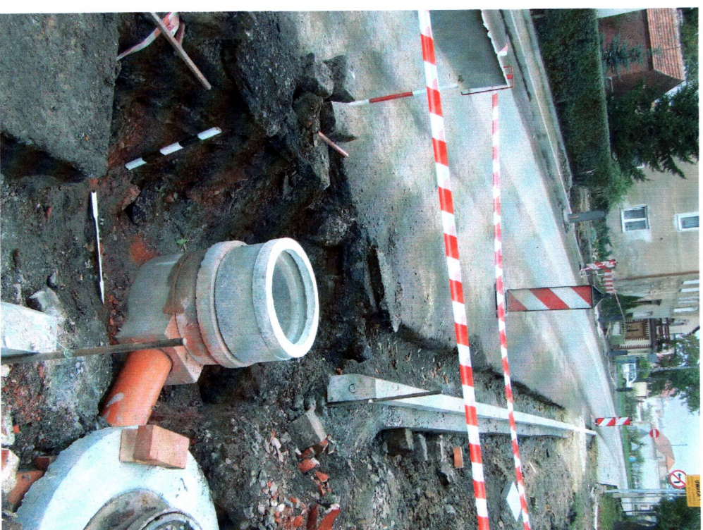
Ryc. 4. Udanie, gm. Ioco. Przebudowa chodnika wraz ze skrzyżowaniem w ciągu dróg powiatowych nr 2078 D i 2091 D (dz. nr 261, 287, i 264): a - skorytowany obszar pod projektowane chodniki w części NW inwestycji; b - widok na części SE inwestycji podczas osadzania studzienki kanalizacyjnej.
