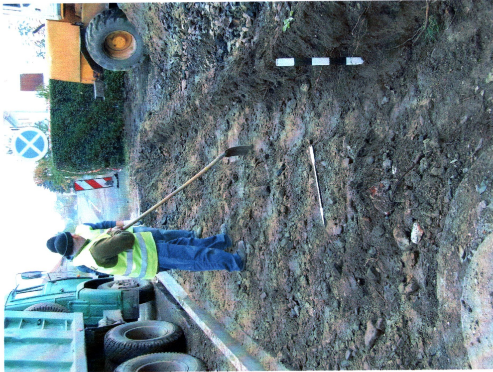
Ryc. 6. Udanin, gm. loco. Przebudowa chodnika wraz ze skrzyżowaniem w ciągu dróg powiatowych nr 2078 D i 2091 D (dz. nr 261, 287, i 264): a - skorytowany obszar pod projektowane chodniki w części NE inwestycji; b - skorytowany obszar pod projektowane chodniki w części SE inwestycji.
