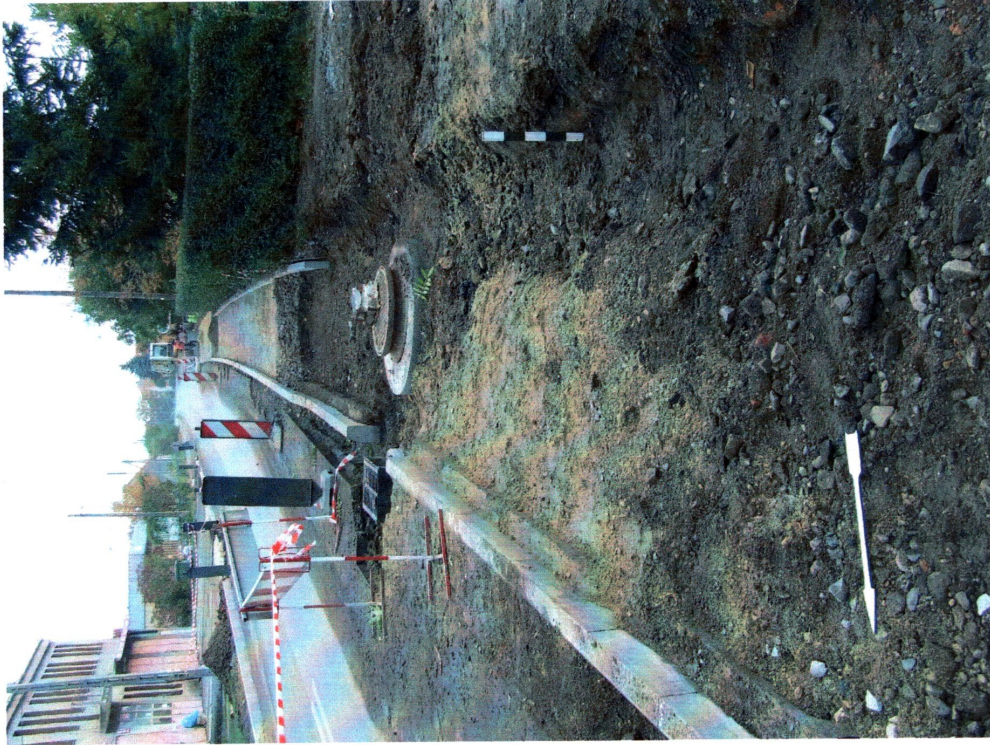
Ryc. 6. Udanin, gm. loco. Przebudowa chodnika wraz ze skrzyżowaniem w ciągu dróg powiatowych nr 2078 D i 2091 D (dz. nr 261, 287, i 264): a - skorytowany obszar pod projektowane chodniki w części NE inwestycji; b - skorytowany obszar pod projektowane chodniki w części SE inwestycji.
