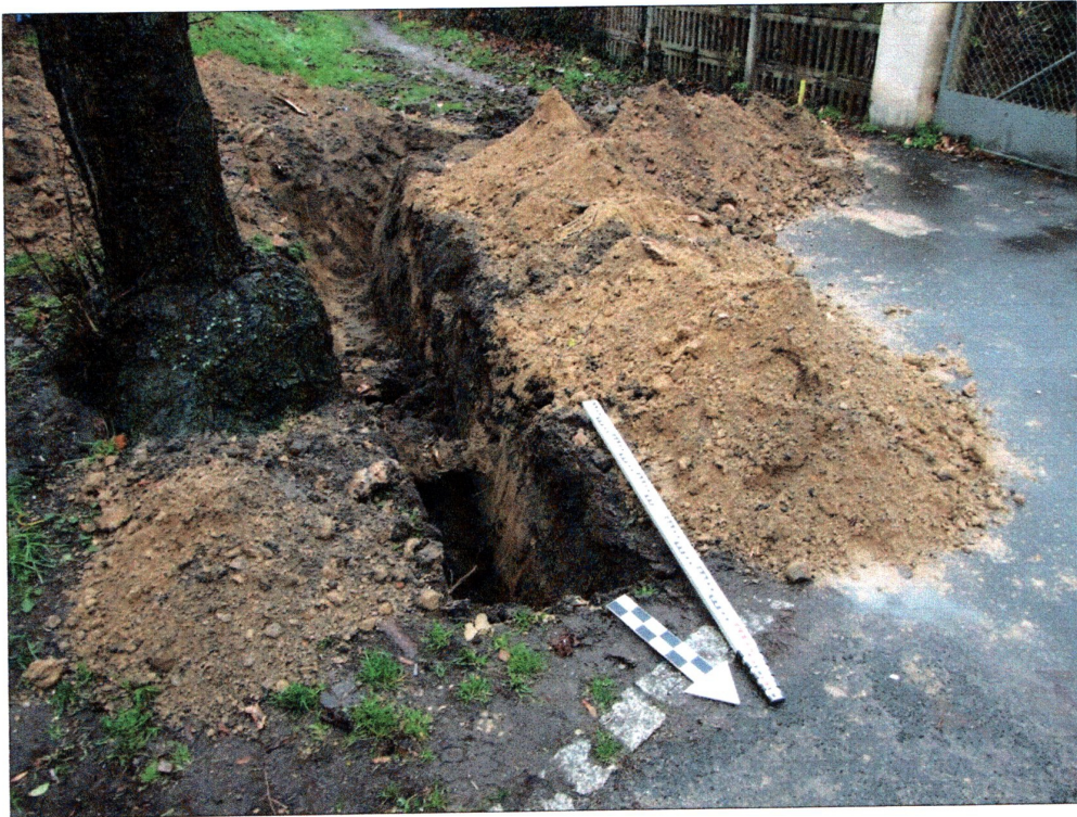
fot. 3 Wykop w środkowej części inwestycji
