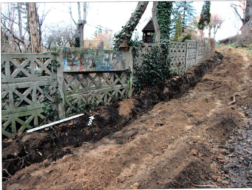
fot. 5 Wykop w południowej części inwestycji
