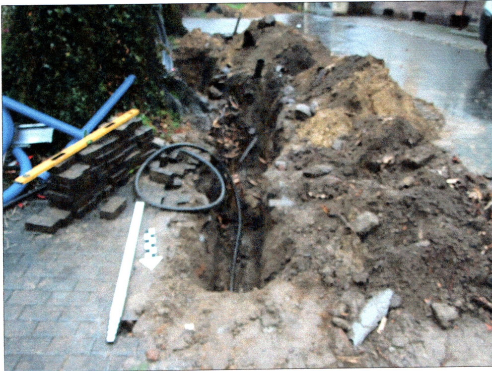
fot. 1 Wykop w północnej części inwestycji
