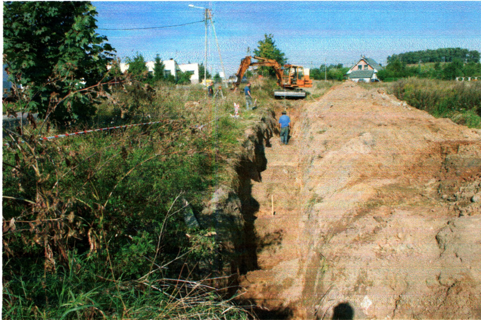
fot. 1 Prace w zachodniej części inwestycji. Widok od NW
