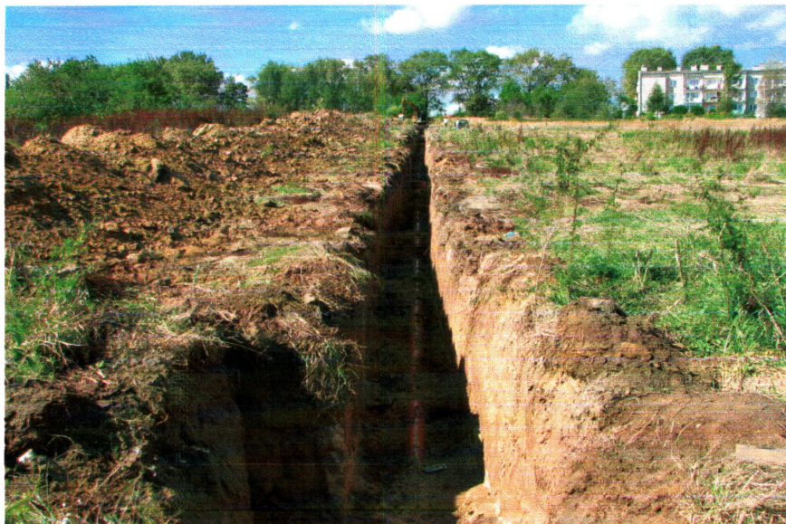
fot. 3 Prace w środkowej części inwestycji. Widok od SW
