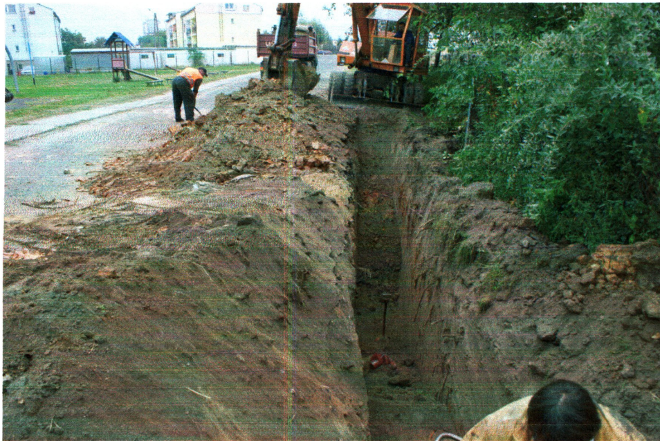
fot. 2 Prace w południowej części inwestycji. Widok od E
