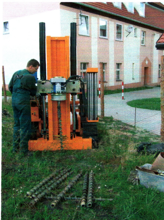
fot. 4 Prace przy odwiercie nr 2
