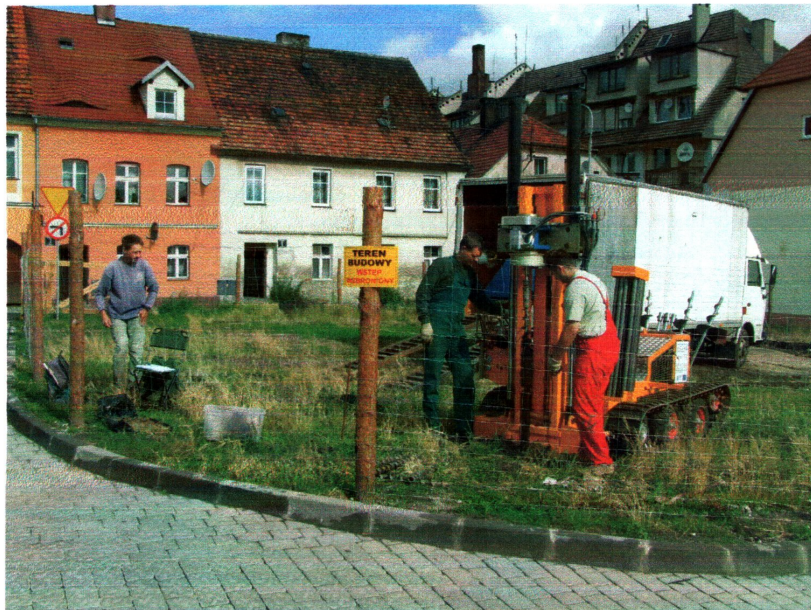
fot. 3 Prace przy odwiercie nr 1
