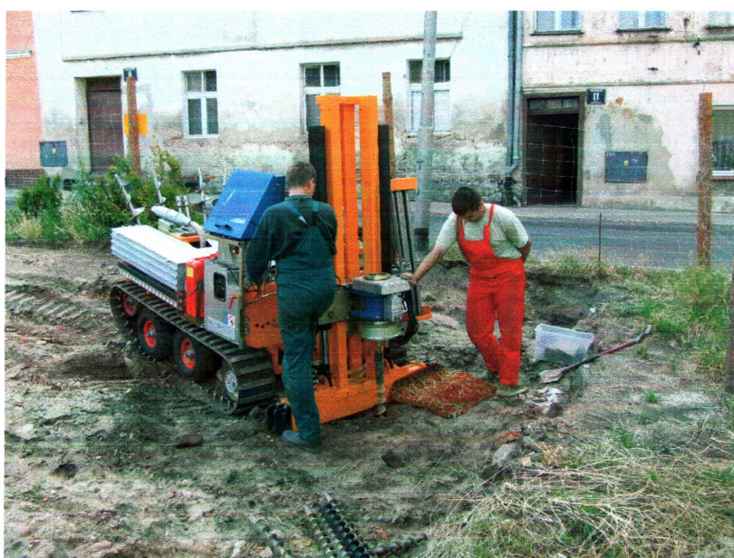
fot. 8 Prace przy odwiercie nr 5
