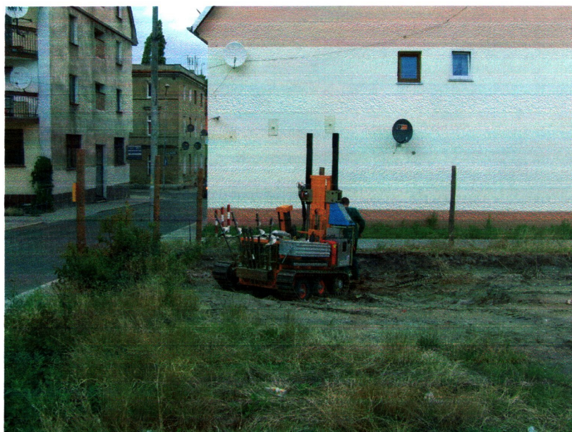
fot. 7 Prace przy odwiercie nr 5
