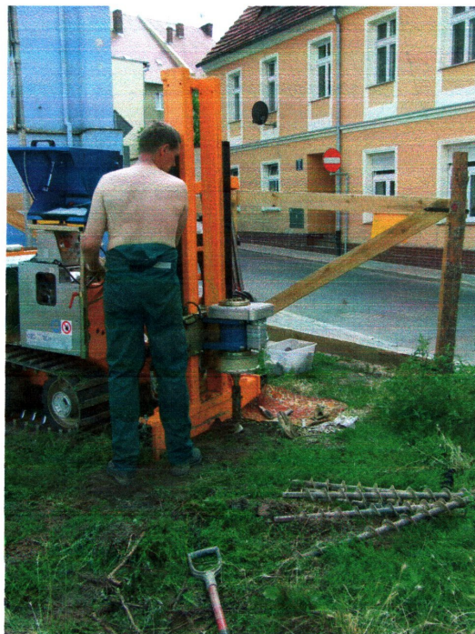
fot. 6 Prace przy odwiercie nr 4
