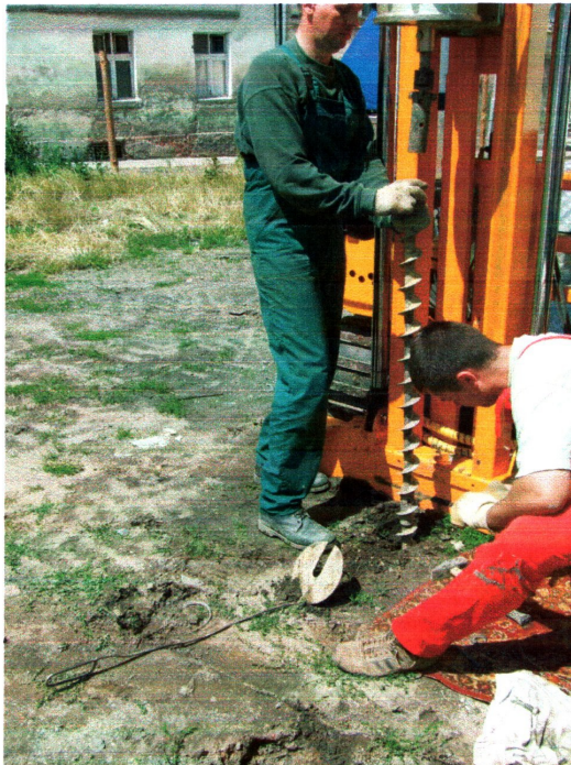
fot. 5 Prace przy odwiercie nr 3
