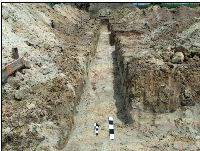
Fot. 5. Lutynia pow. Średzki dz. Nr 264/32. Wykop fundamentowy pod ścianę zachodnią budynku. Widok z południa
