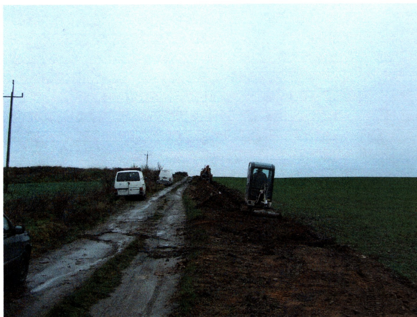
Fot. 13) Godków-Paździorno-Osieczyna gm. Kostomłoty. Prace około połowy odcinka do Osieczyny. Widok z południa
