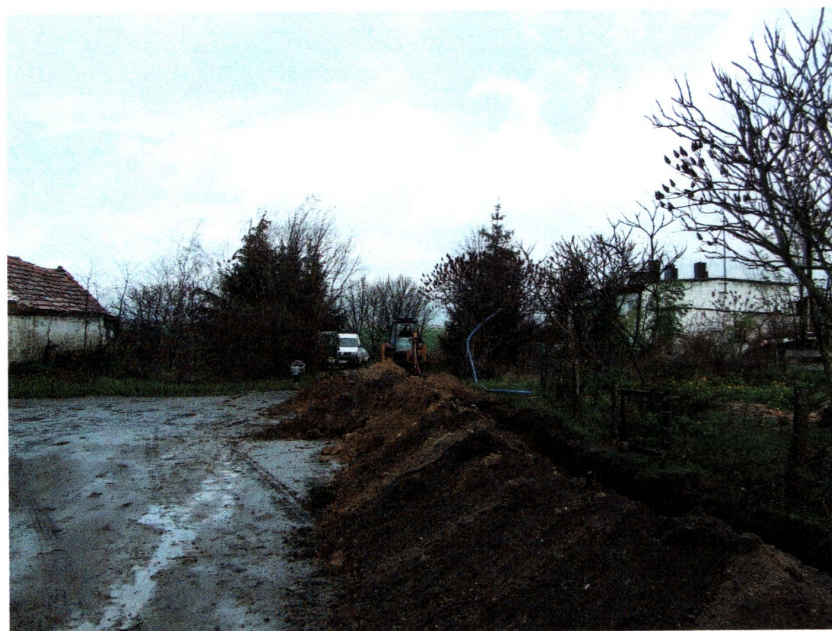
Fot. 20) Godków-Paździorno-Osieczyna gm. Kostomłoty. Wykopy w obrębie Osieczyny. Widok z południa
