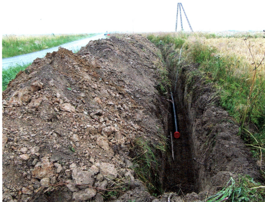
Fot. 9) Godków-Paździorno-Osieczyna gm. Kostomłoty. Wschodni kraniec inwestycji w rejonie Paździorna. Widok ze wschodu
