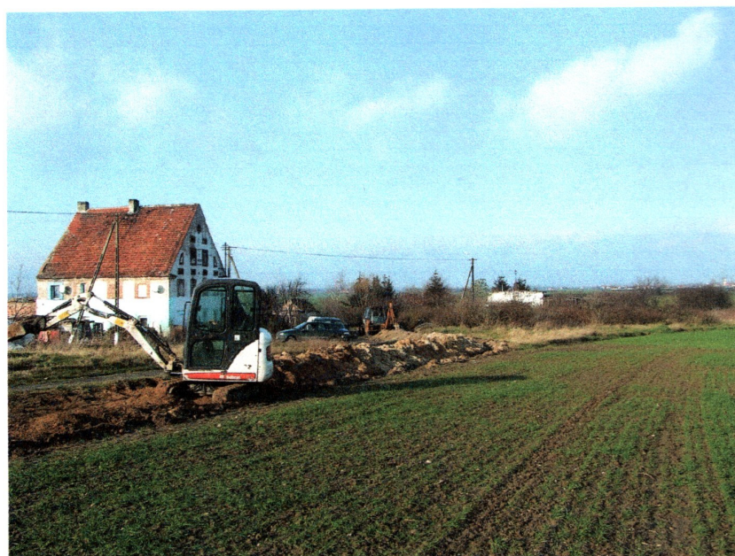
Fot. 18) Godków-Paździorno-Osieczyna gm. Kostomłoty. Prace na skraju Osieczyny. Widok z południa
