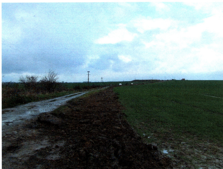
Fot. 11) Godków-Paździorno-Osieczyna gm. Kostomłoty. Prace ziemne w kierunku Osieczyny. Widok z południa ze skrzyżowania z drogą Godków-Paździorno
