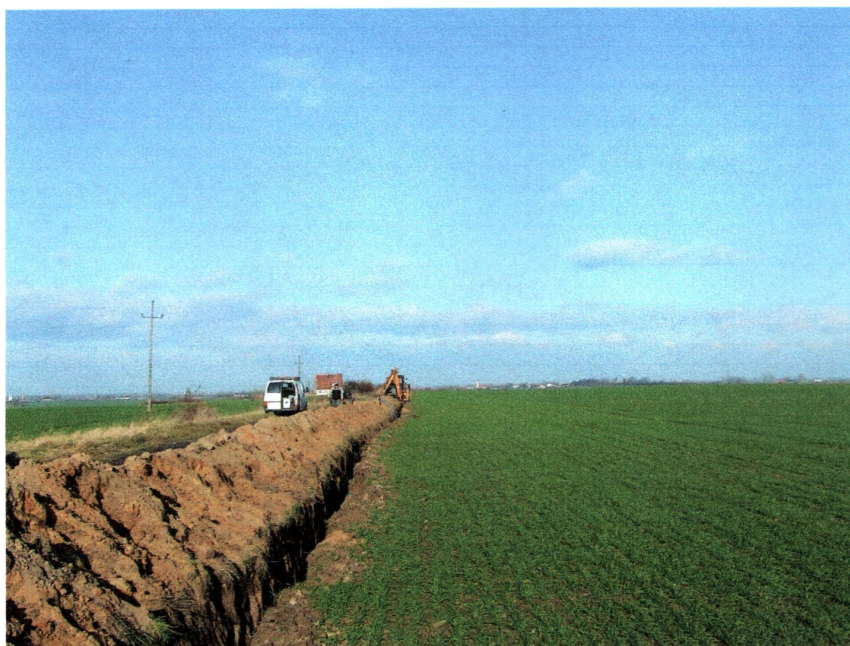
Fot. 15) Godków-Paździorno-Osieczyna gm. Kostomłoty. Widok na inwestycję w rejonie Osieczyny. Widok z południa
