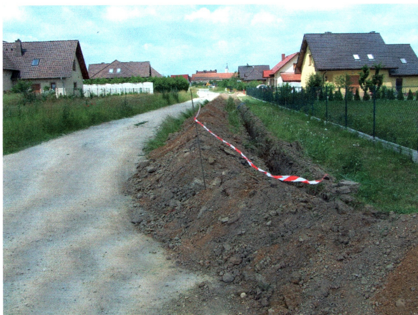
Fot. 7) Kostomłoty pow. średzki. Widok wykopów instalacyjnych w ulicy Jaśminowej w kierunku zbiegu z ulicą Sportową. Widok ze wschodu
