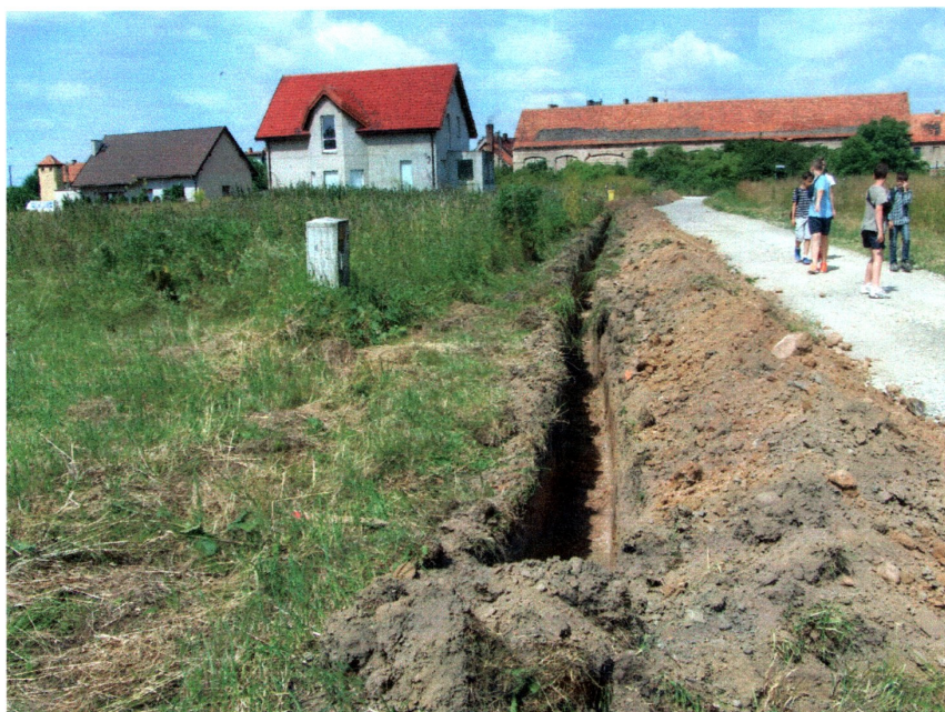
Fot. 3) Kostomłoty pow. średzki. Widok ze wschodu na centralną część wykopu instalacyjnego w ulicy Klonowej
