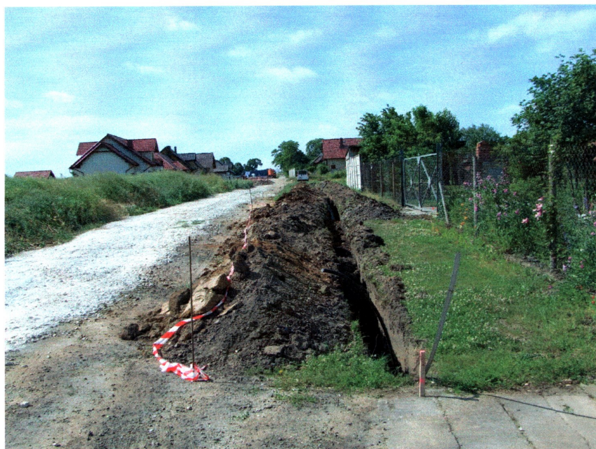
Fot. 8) Kostomłoty pow. średzki. Widok na północną część wykopu instalacyjnego w ulicy Sportowej. Widok z północy
