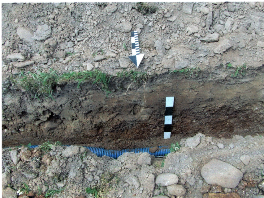
Fot. 9) Kostomłoty pow. średzki. Profil zachodni wykopu instalacyjnego w północnej części ulicy Sportowej (P4). Widok ze wschodu
