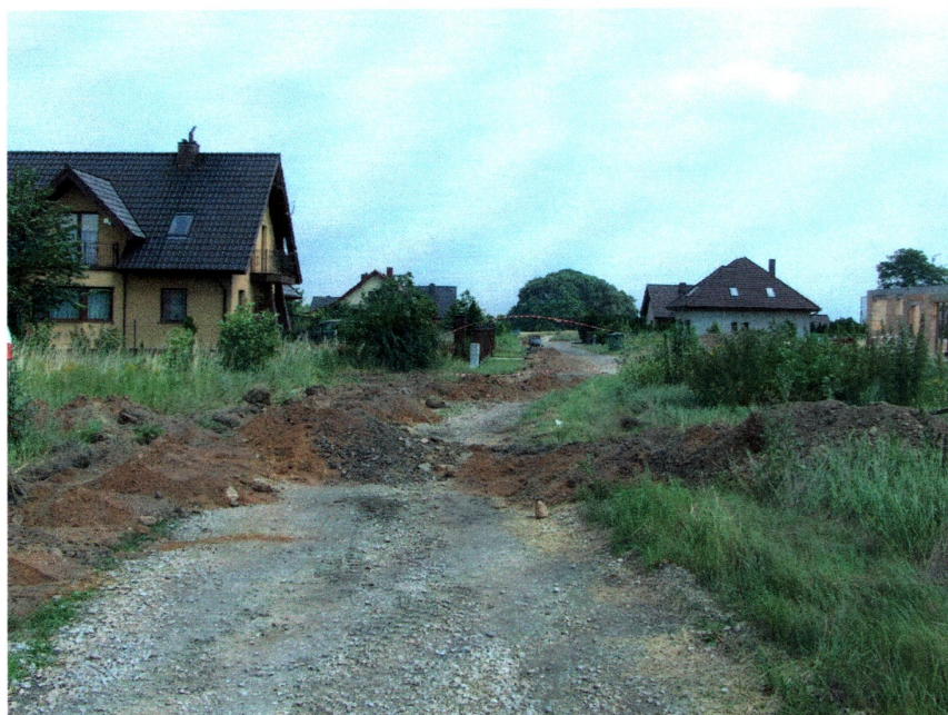
Fot. 10) Kostomłoty pow. średzki. Widok na wykopy instalacyjne w ulicy Klonowej w kierunku zbiegu z ulicą Sportową. Widok z zachodu
