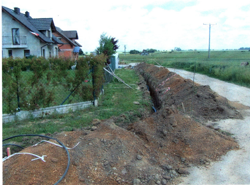
Fot. 5) Kostomłoty pow. średzki. Wykop instalacyjny w krańcu ulicy Jaśminowej. Widok z południa
