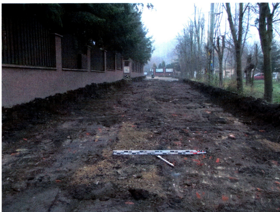
Fot. 2) Środa Śląska ul. Mostowa rejon posesji nr 22, 22b. Widok na obszar badań z północy
