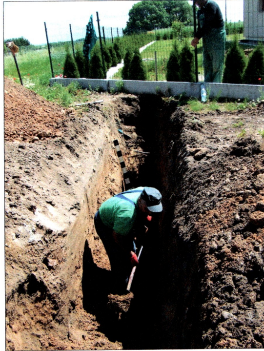
fot. 8 Nadzór nad pracami w południowej części inwestycji, na wysokości działki nr 193/3
