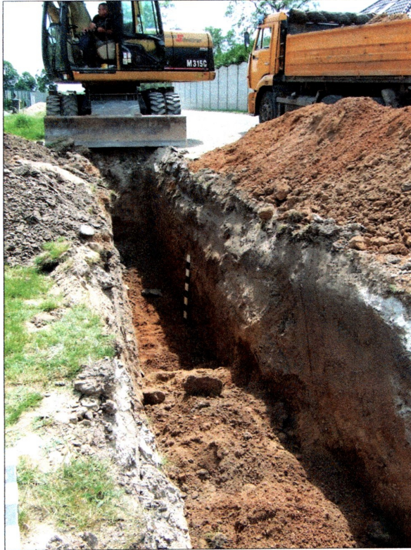
fot. 3 Nadzór nad pracami w północnej części inwestycji, na wysokości działki nr 196
