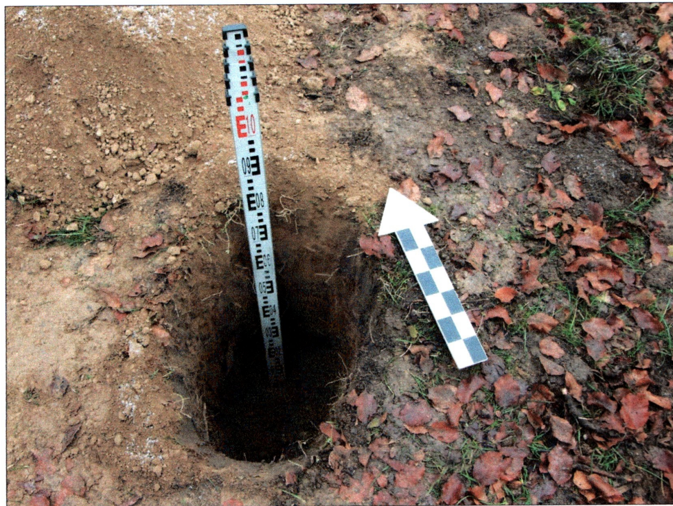
fot. 2 Wykop pod słup nr 2
