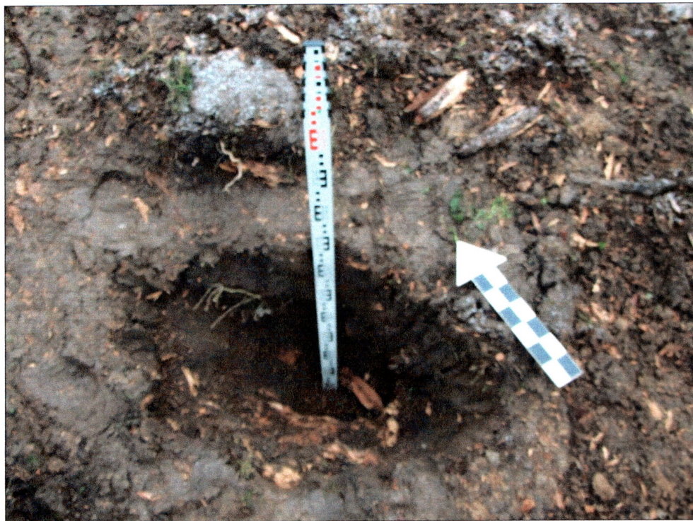
fot. 4 Wykop pod słup nr 4
