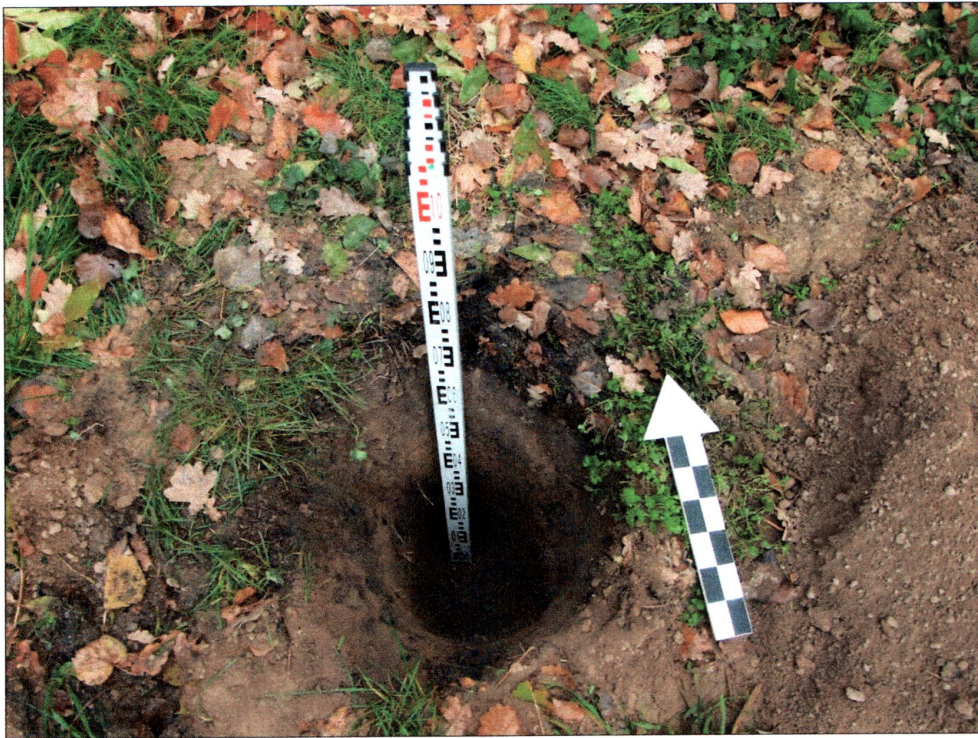
fot. 6 Wykop pod słup nr 6
