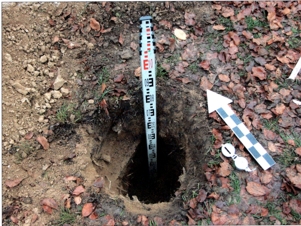
fot. 1 Wykop pod słup nr 1
