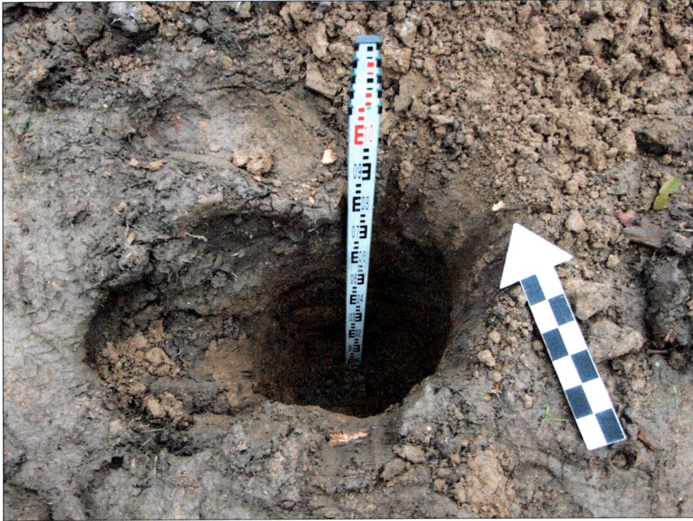
fot. 5 Wykop pod słup nr 5
