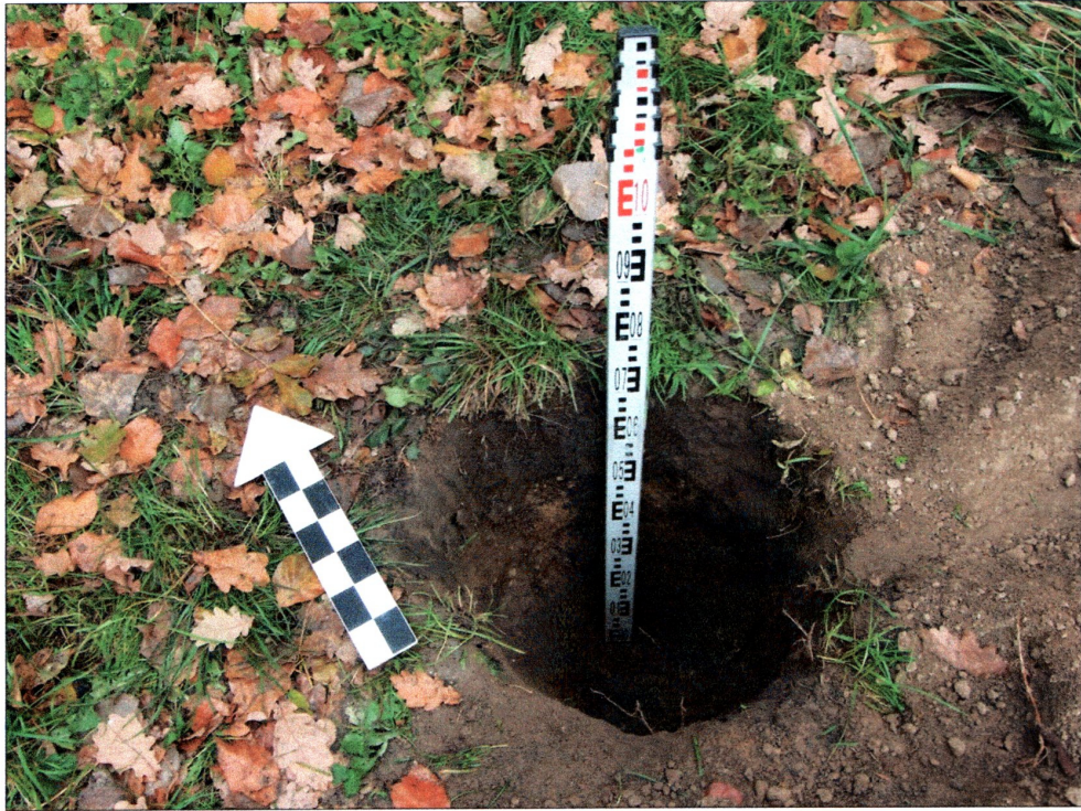
fot. 7 Wykop pod stupa nr 7
