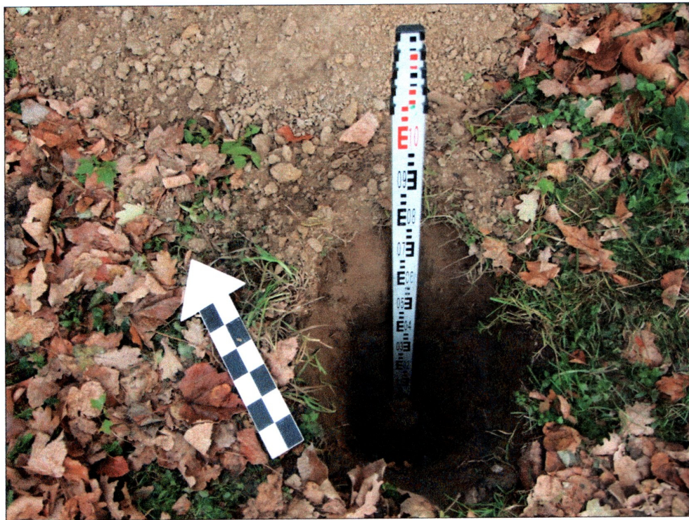
fot. 10 Wykop pod słup nr 10
