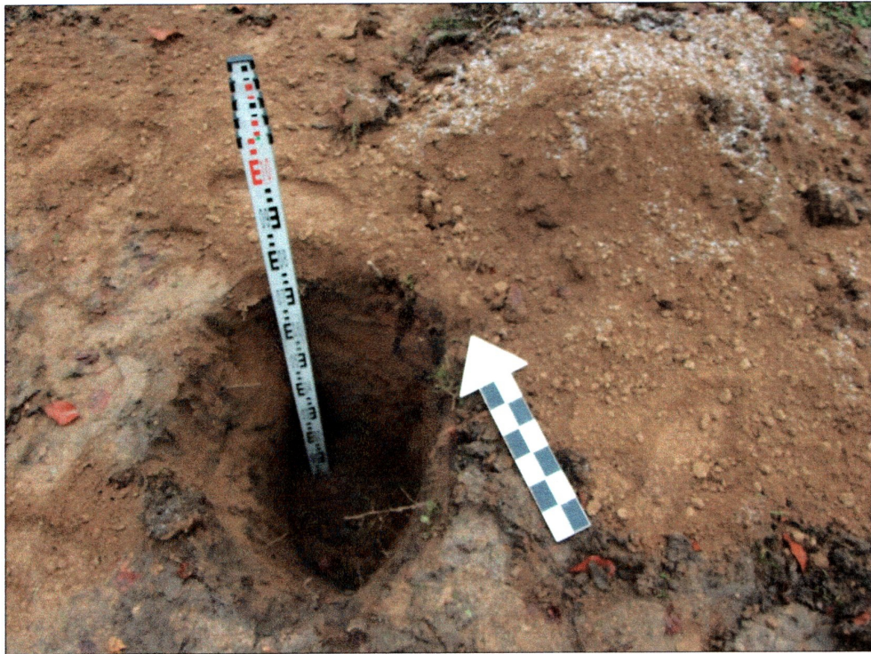
fot. 3 Wykop pod słup nr 3
